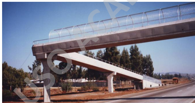
Imagen 7: Pasarela peatonal prefabricada de hormigón.
