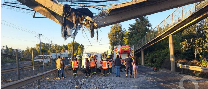
Imagen 9: Pasarela peatonal colapsa luego de ser impactada por un camión.
