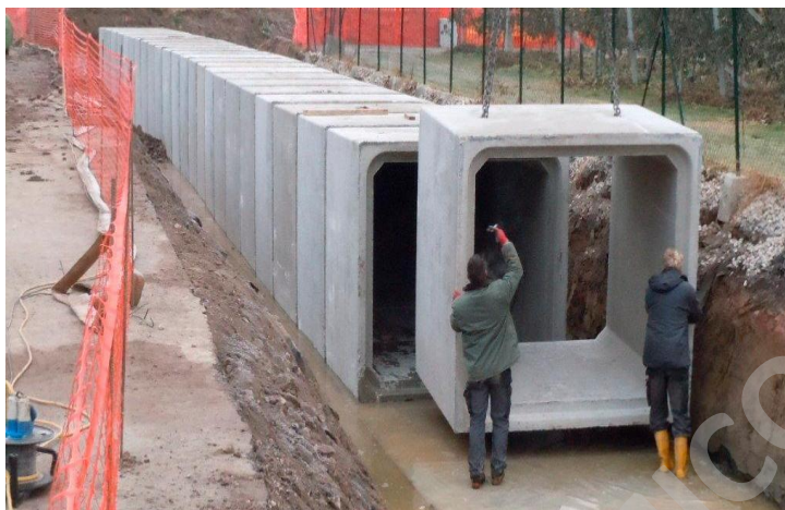
Imagen 10: Módulos prefabricados de hormigón.
