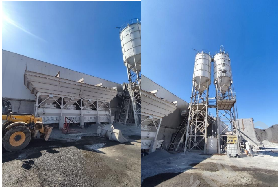
FIGURA 5: PROCESO DE HORMIGÓN
