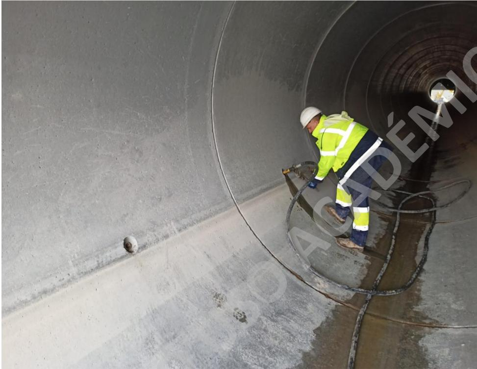
Nota. *Inyecciones de lechada de cemento* [Fotografía], Cimsur, 2023.
