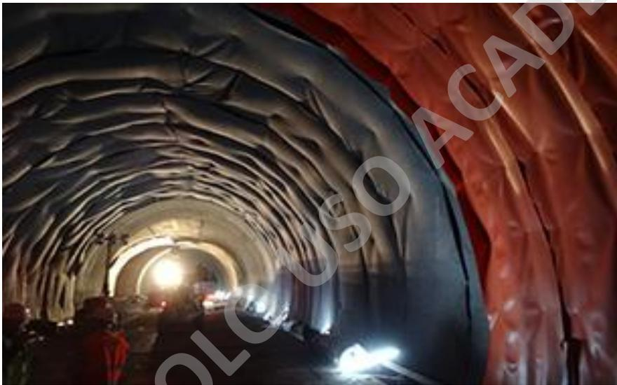
Nota. Sistemas de impermeabilización de túneles. [Fotografía], TDM Chile, 2017.
