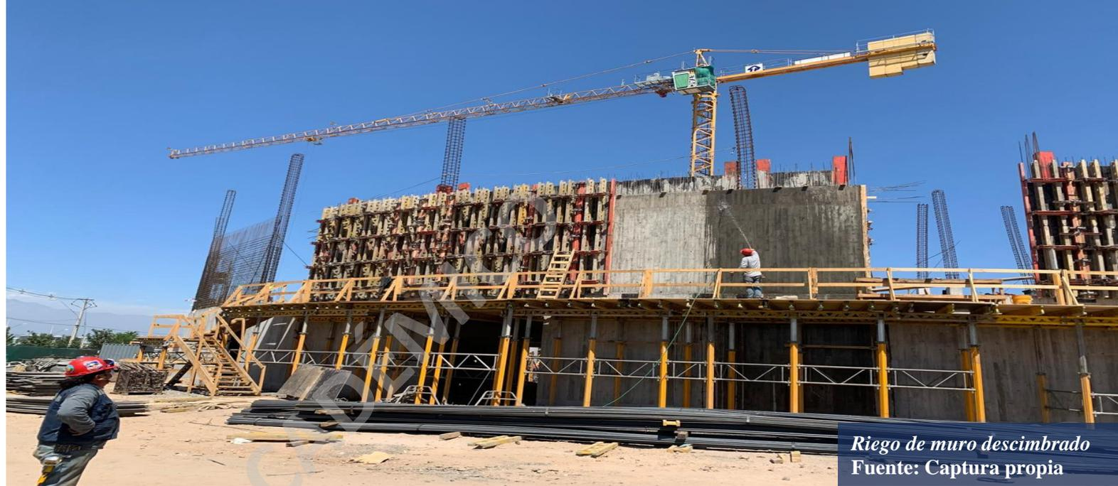
*Riego de muro descimbrado*
