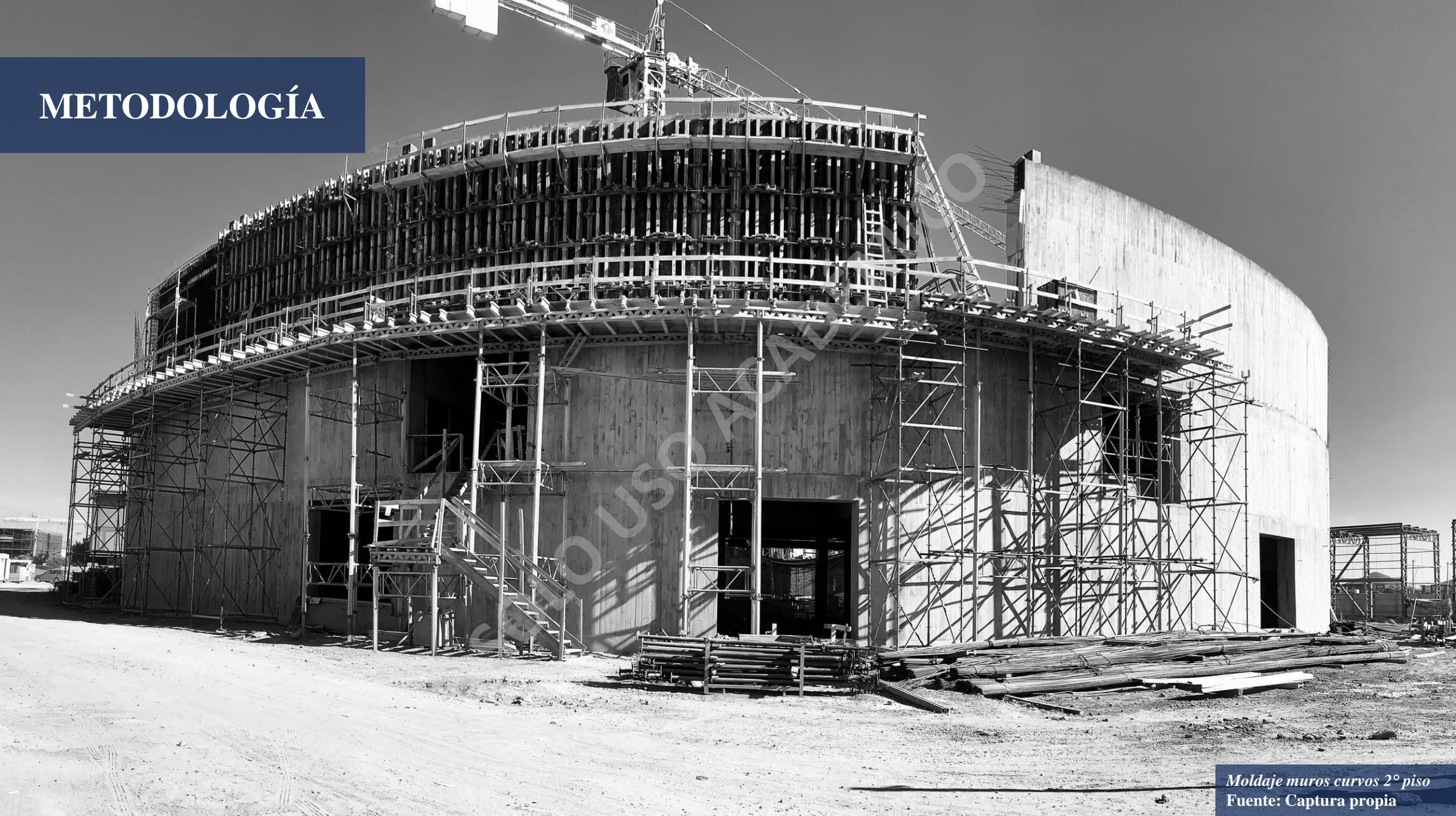
*Moldaje muros curvos 2° piso*
