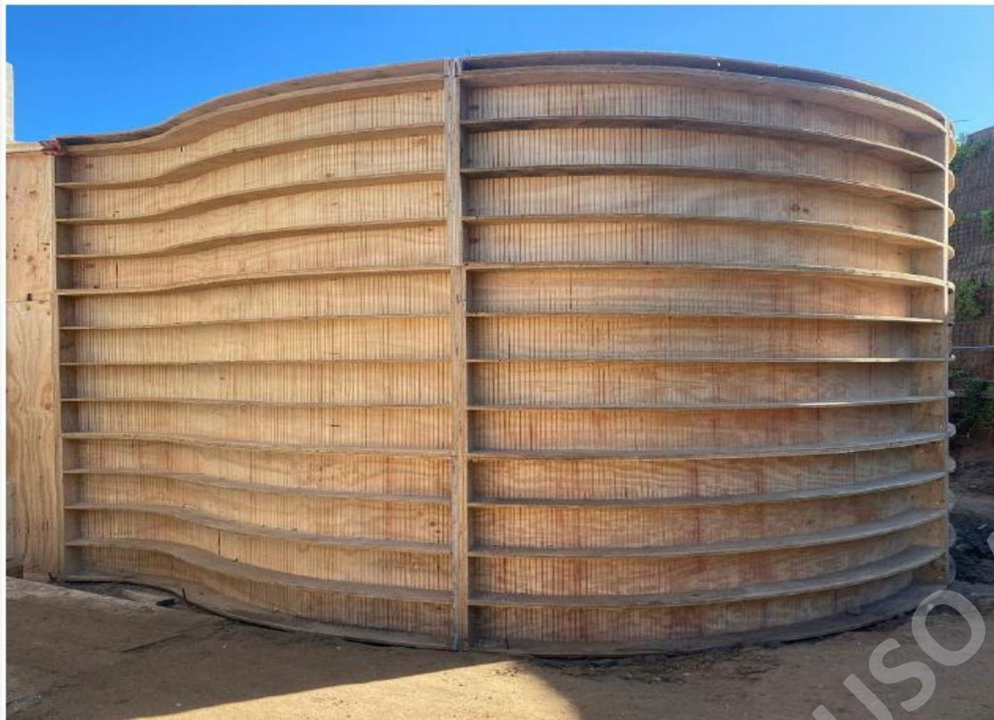
Nota. Con una fresadora de hacer cortes vertivales de tal forma que posibilita curvar la placa de terciado. Foto tomada de (CONSTRUCTORA C1, 2022)
