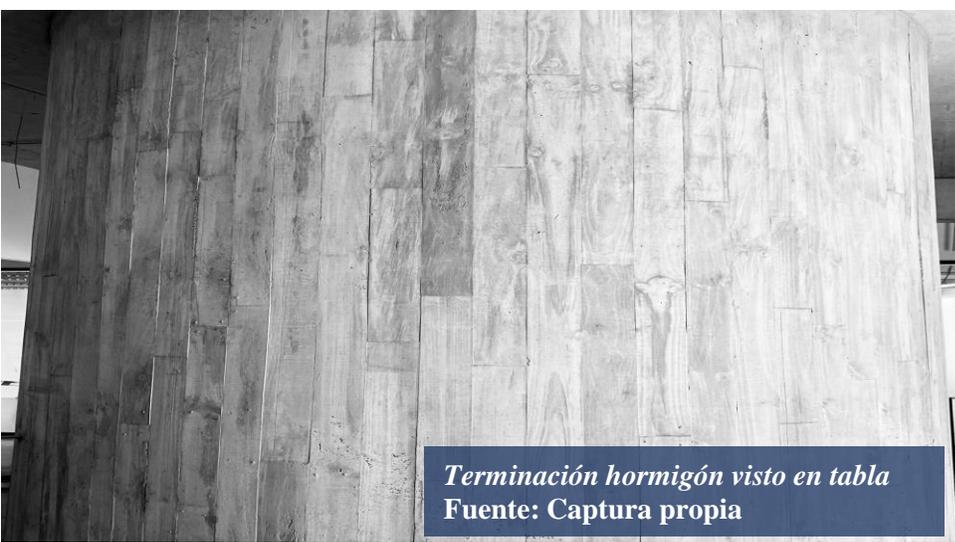
*Terminación hormigón visto en tabla*
