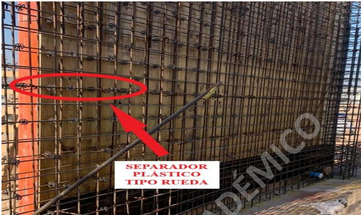
Nota. Separadores instalados en el muro de fachada terminación de hormigón visto de Edificio Floramatic previa instalación de moldaje. Fuente propia
