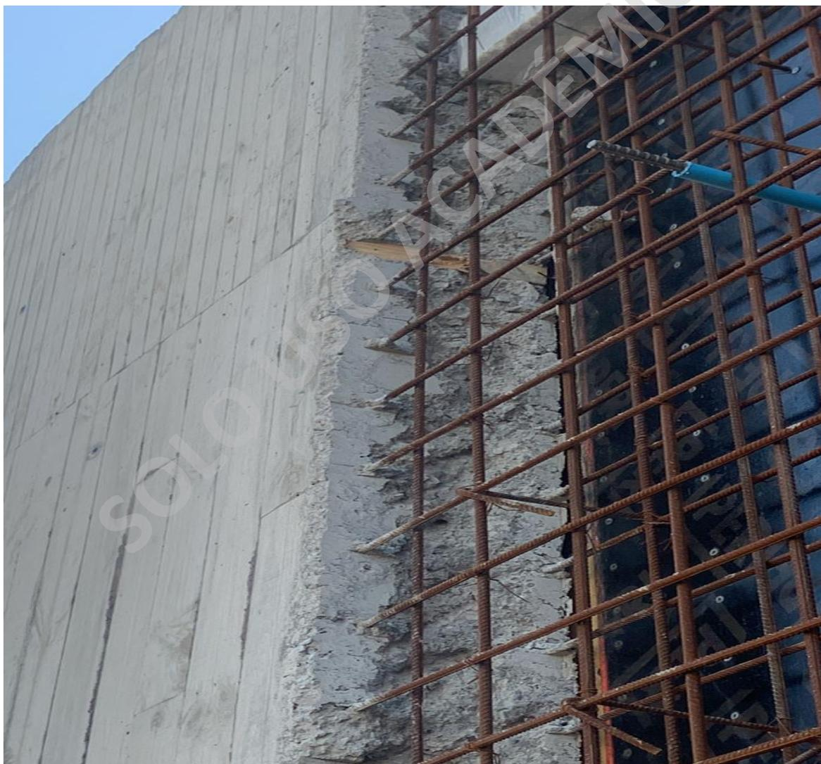
Nota. Posición de la armadura de muro está posicionada de tal forma que deja más recubrimiento de hormigón en la cara de hormigón visto. Fuente Propia
