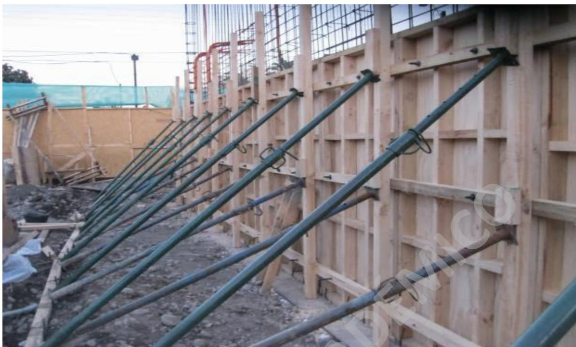
Nota. Moldaje de Madera confeccionado en obra con placa de terciado, reforzado con bastidores, vigas, crucetas y alineadores de pino bruto. Se colocaron alzaprimas para apuntalar y que cumplan la función de aplomadores. Tomada de (Suazo, 2014)
