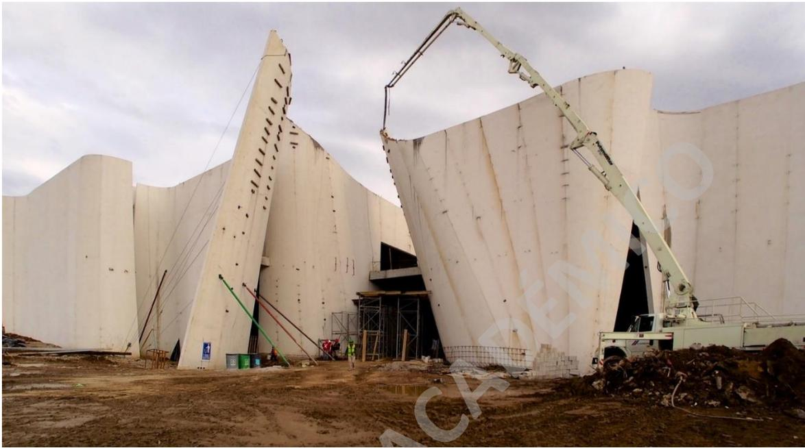
Nota. Proceso de izaje y anclaje de los muros de la fachada del MIB. Tomada de (ArchDaily Team, 2017)
