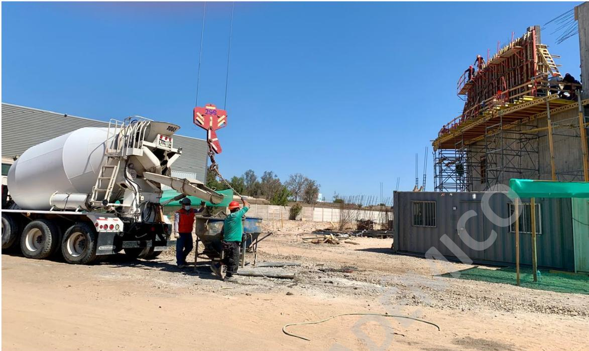
Nota. Proceso de carga de capacho con hormigón para ser colocado en un muro de fachada del Proyecto Floramatic. Fuente Propia
