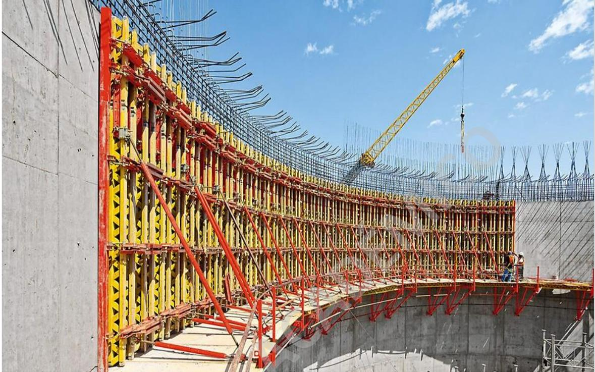
Nota. Ejemplo de curvatura del Moldaje PERI tipo RUNDFLEX. Tomada de (PERI, 2024)
