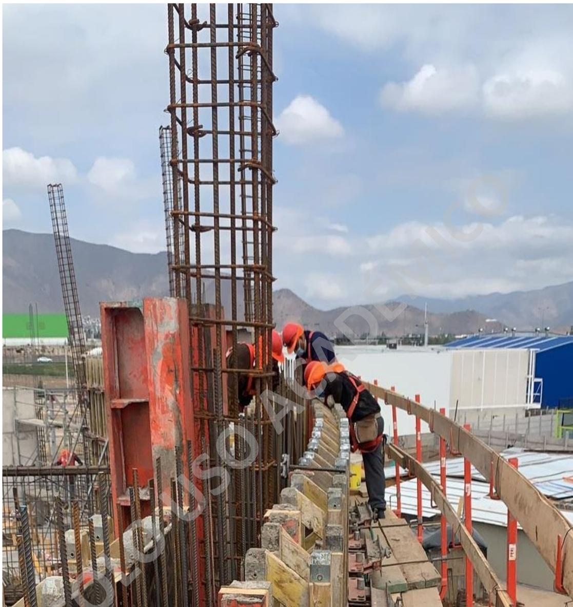
Nota. Carpinteros de la empresa Constructora Jorge Carrasco Farías revisan la hermeticidad y curvatura del encofrado tipo RUNDFLEX correspondiente a la fachada de hormigón visto Proyecto Floramatic. Fuente Propia.
