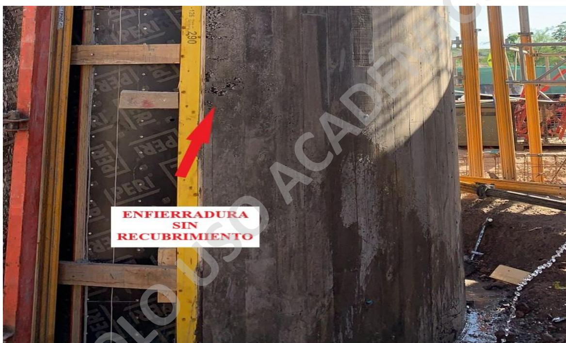
Nota. Falla en la terminación de hormigón visto por no asegurar el uso de separadores en cabezal de muro de caja ascensor con muros curvos Proyecto Floramatic. Fuente Propia.
