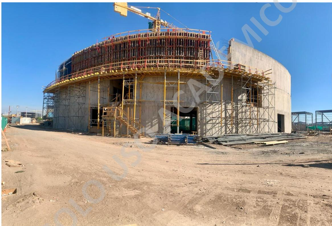
Nota. Cara exterior del moldaje tipo Rundflex. Fuente propia.
