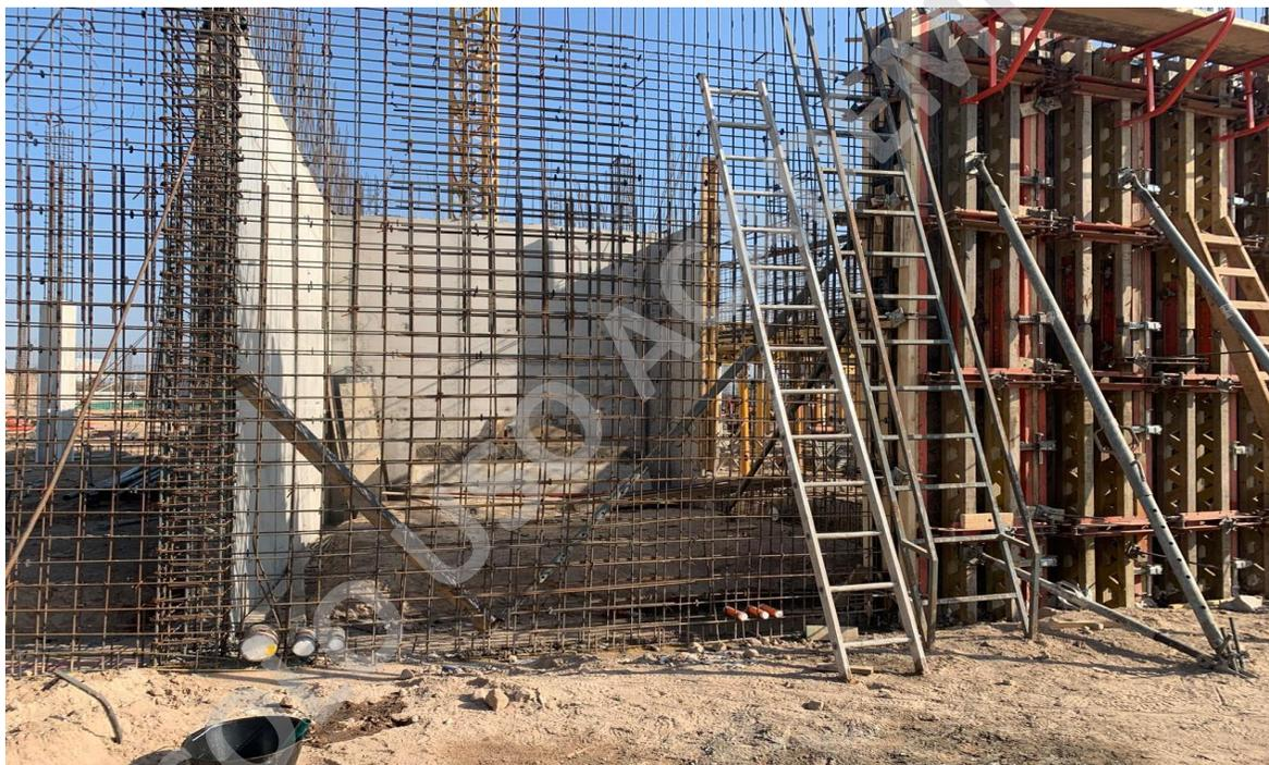
Nota. Muro con enfierradura terminada listo para tapar con moldaje. Fuente propia.
