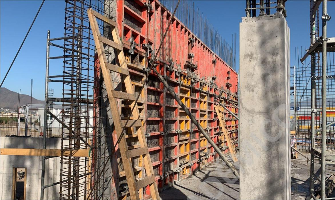
Nota. Moldaje Metálico de un muro recto de 2° Nivel del Edificio antes de ser descimbrado. Fuente Propia.
