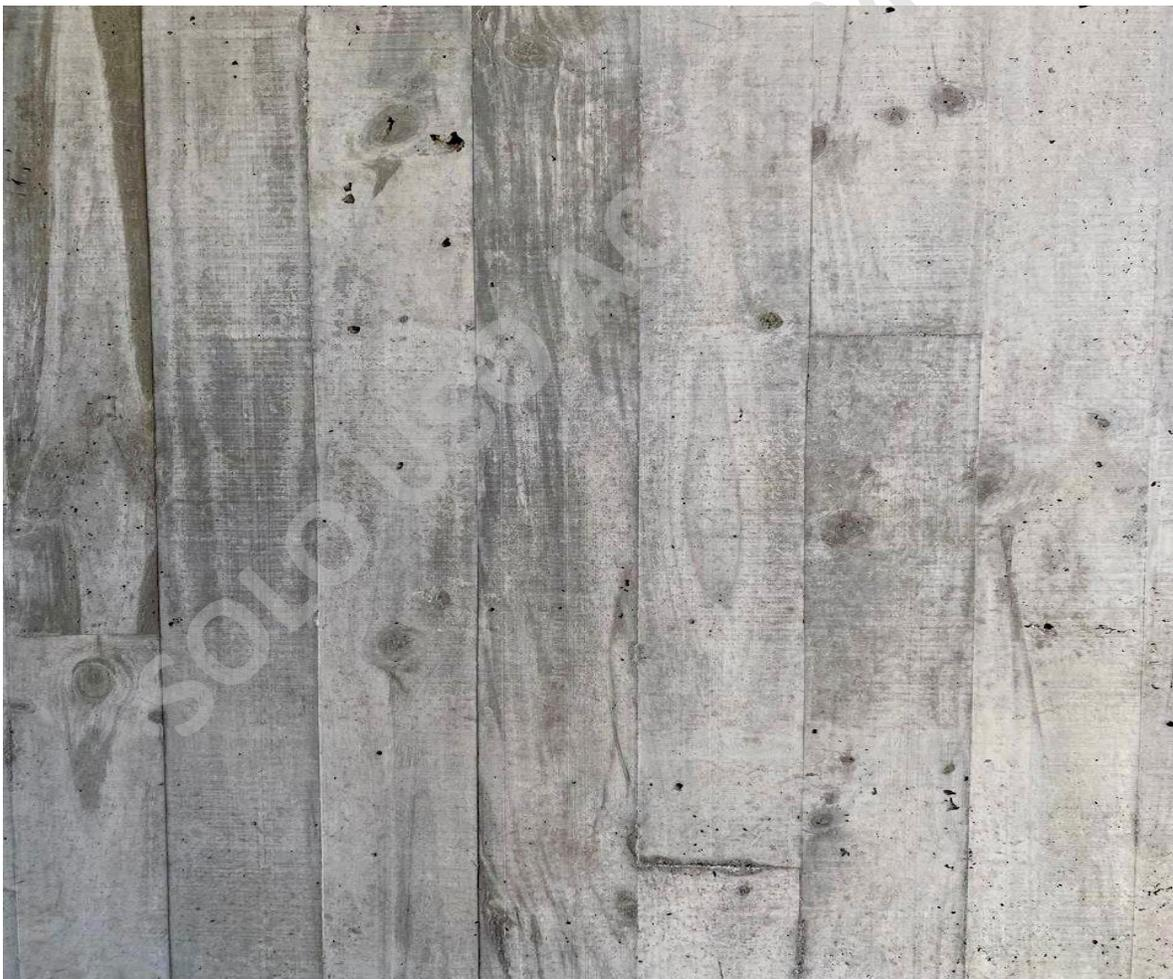
Nota. Terminación de los muros de fachada exterior Edificio Floramatic, en donde se observa como el hormigón tomo la textura de la tabla, incluyendo tonalidades, nudos y vetas. Fuente propia.
