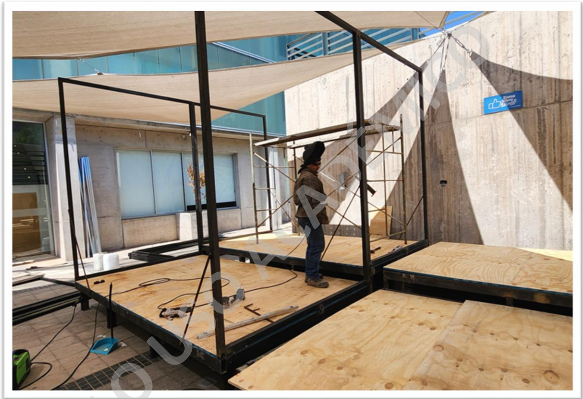
Imagen N°3: Proceso de construcción de locales de comida
