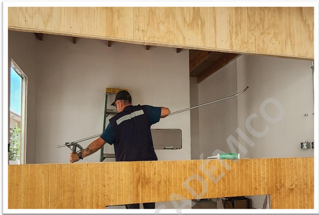
Imagen N°6: Proceso de canalización eléctrica exterior de muro
