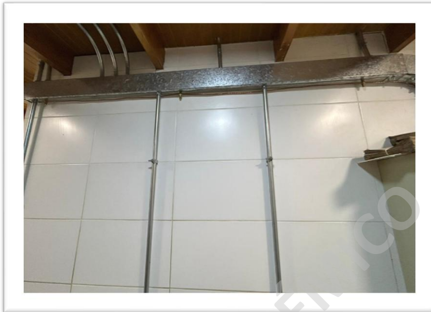
Imagen N°7: Proceso de canalización eléctrica exterior de muro
