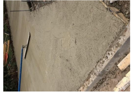
Imagen N°14 Llana fresco en función.
