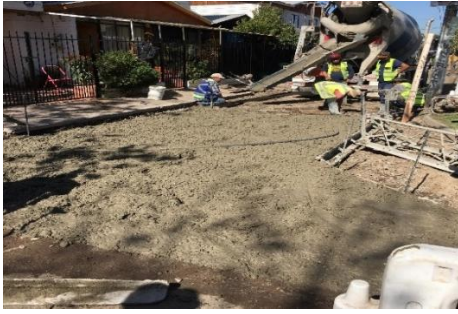
Imagen N°13 Proceso de hormigonado.
