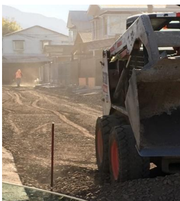
Imagen N°11 Instalación de Base con minicargador.
