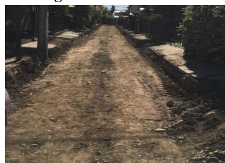
Imagen N°10 Subrasante ya compactada.
