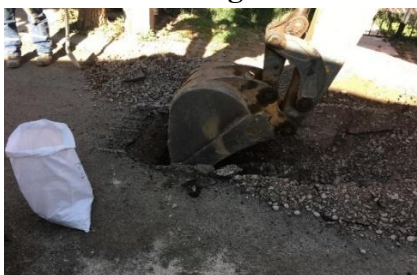
Imagen N°7 Calicata para evaluar subrasante.
