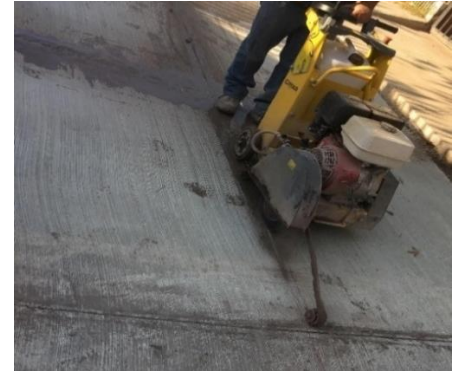
Imagen N°16 Cortadora de juntas.
