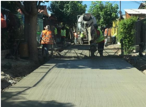
Imagen N°15 Cercha vibradora.
