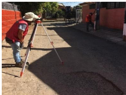
Imagen N°6 Levantamiento topográfico de perfil longitudinal.
