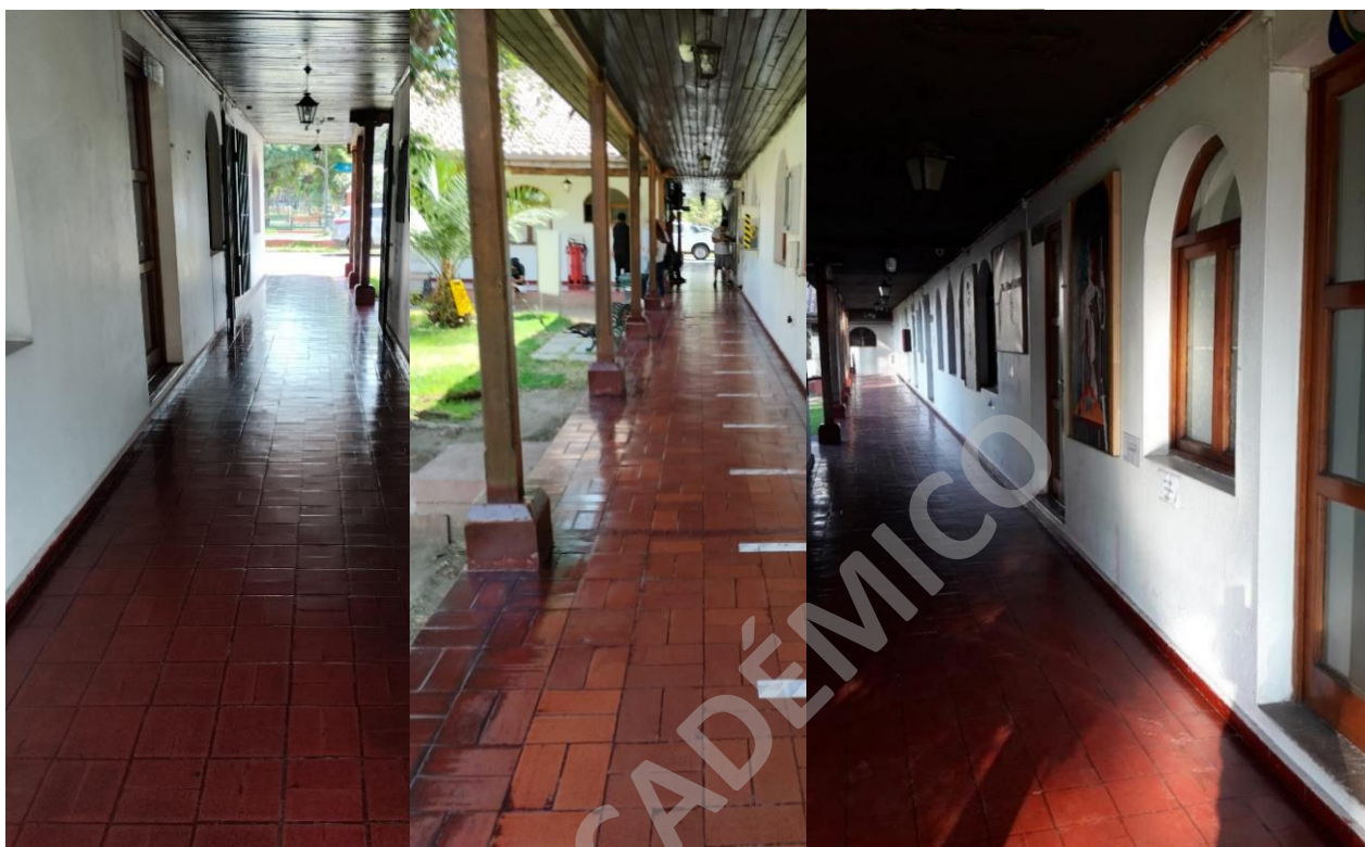
Ilustración 34: Pasillo interno de la municipalidad.
