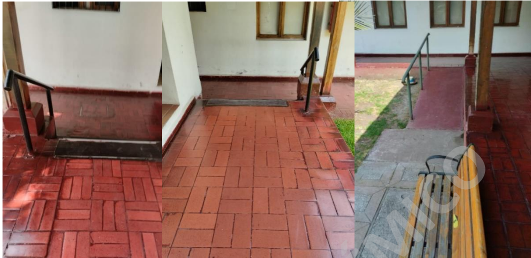
Ilustración 36: Escaleras y rampa
