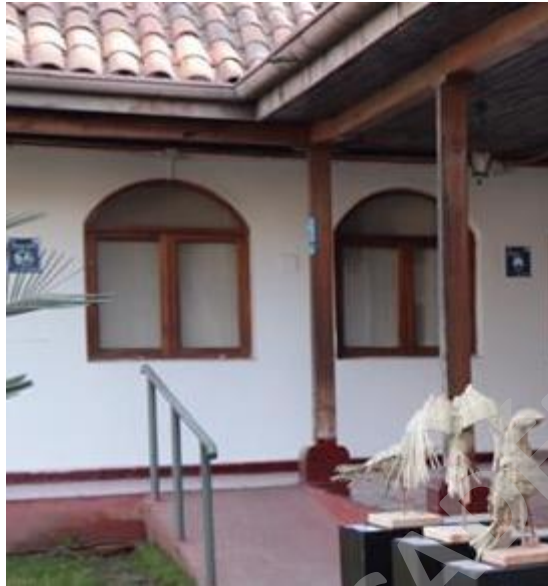
Ilustración 35: Pasamanos para ingresar a los pasillos internos
