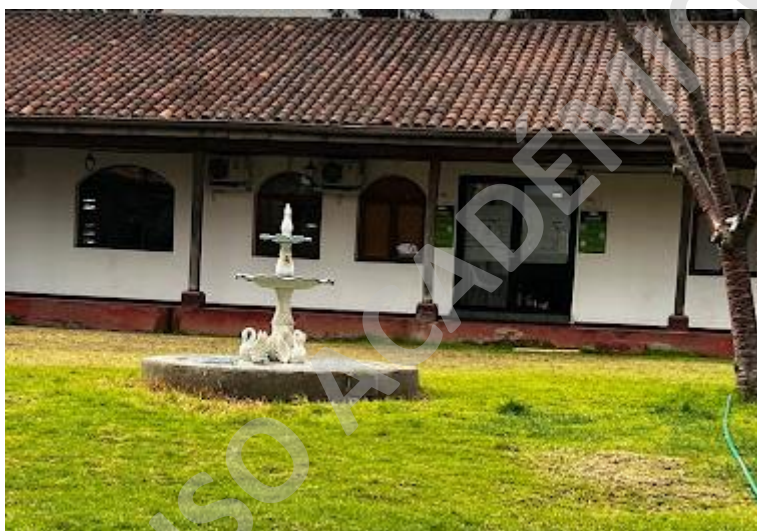
Ilustración 33: Patio interior y pasillo interno
