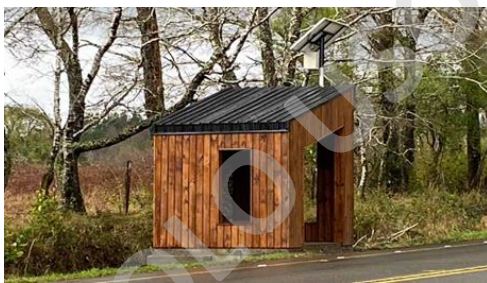
Imagen N°10 – Temuco Televisión (Victoria Araucanía,2020) Foto de uno de los paraderos construidos en sectores rurales de Victoria.
