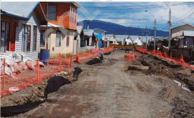
Figura 3: Preparación de Subrasante
