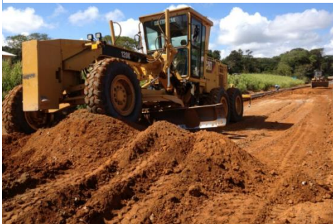
Figura 2: Trabajo de movimiento de tierras para pavimentos.
