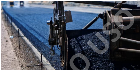
Figura 6: Mezcla Asfáltica en Caliente
