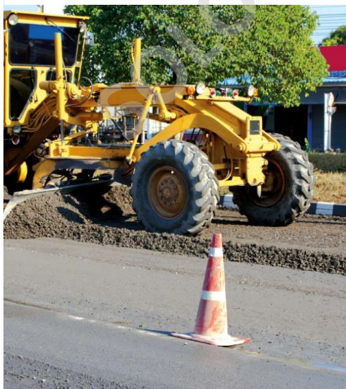
Figura 4: Trabajos de Subbase y Base Estabilizada para Pavimentos.
