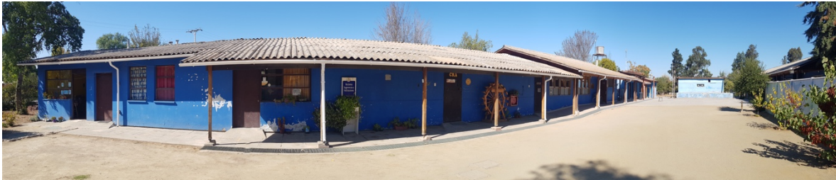
Imagen N°13: Panorámica del ala antigua de la Escuela Básica San José
