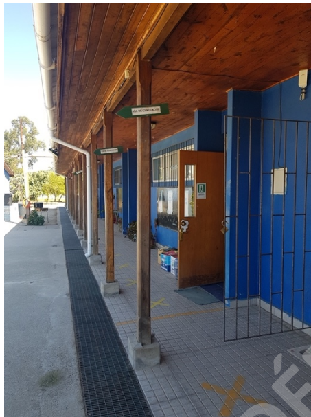
Imagen N°15: Pasillo del ala nueva de la Escuela
