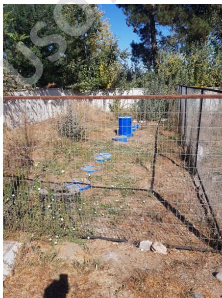
Imagen N°16: Planta de tratamiento aguas servidas de la Escuela
