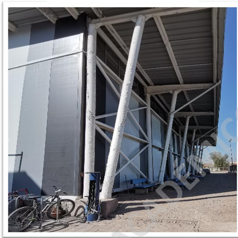
Imagen N°24: Vista lateral gimnasio.
