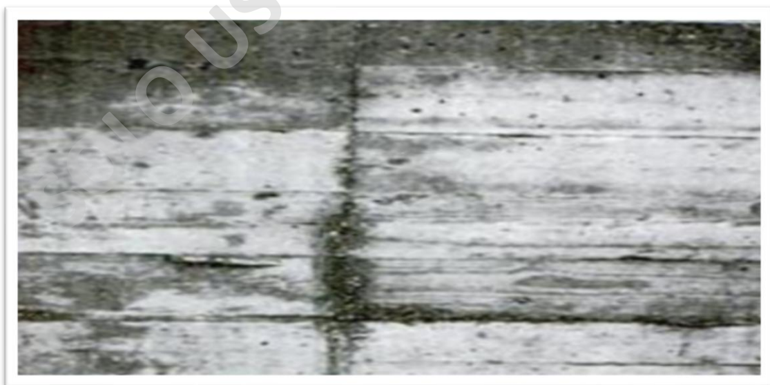
Imagen N°9: Acabado con moldaje sin permeabilidad.
