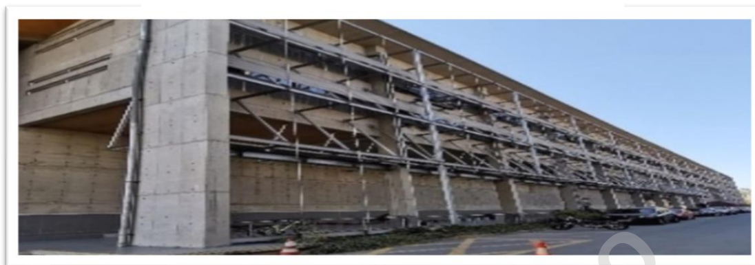
Imagen N°16: Fachada ventilada escuela ingeniería.
