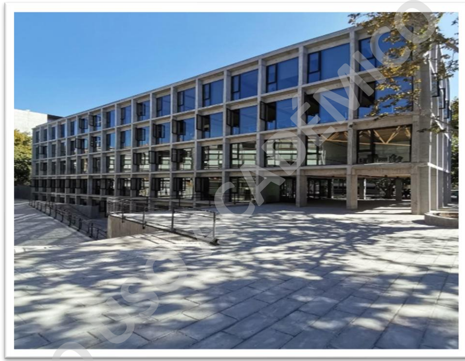
Imagen N°31: Vista acceso y frontis edificio biblioteca y multiuso.
