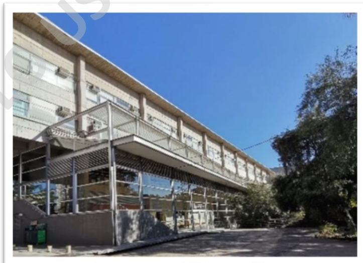
Imagen N°15: Vista lateral escuela ingeniería.
