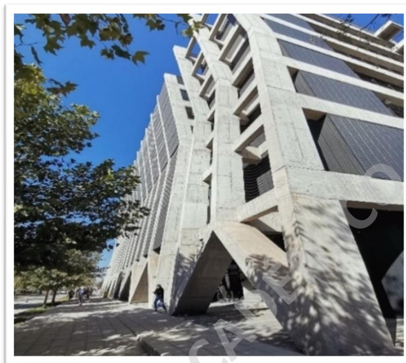
Imagen N°20: Vista lateral edificio multiuso.
