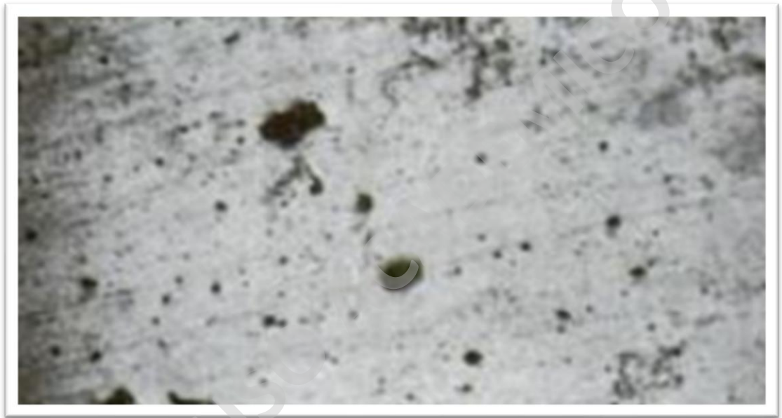
Imagen N°3: Presencia de burbujas superficiales.
