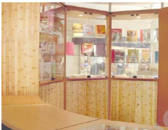
Figura 7. Revestimiento de muros con tableros laminados de bambú chileno.
