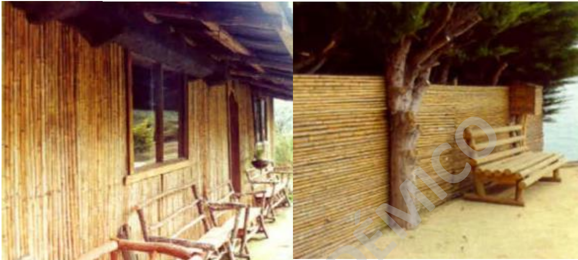
Figura 1. Uso del bambú chileno como revestimiento y cerco
