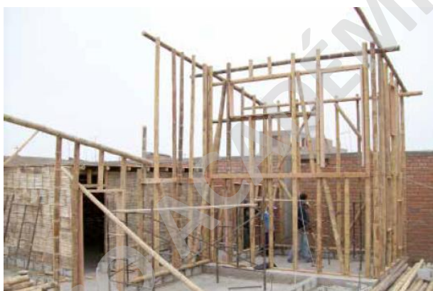
Figura 4. Uso estructural del bambú
