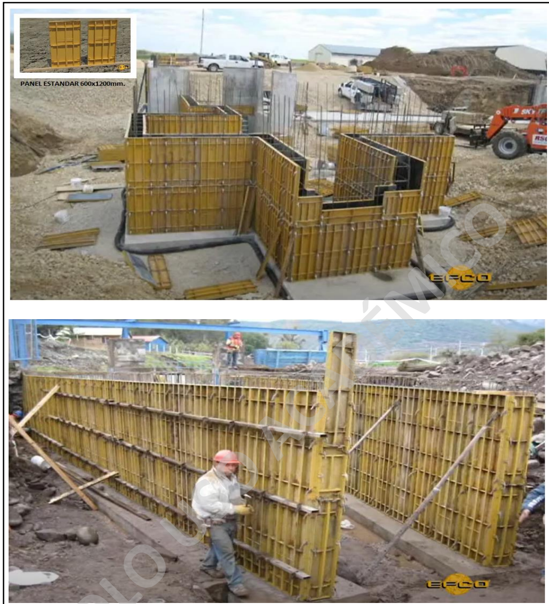
Figura N°9: Montaje en obra sistema Hand E Form.
