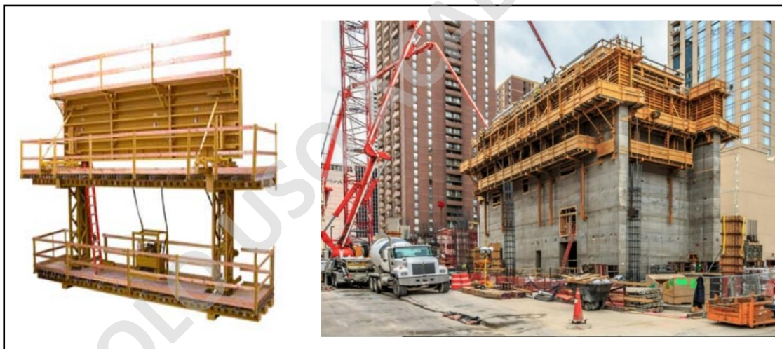
Figura N°10: Sistema autotrepante montado en obra.
