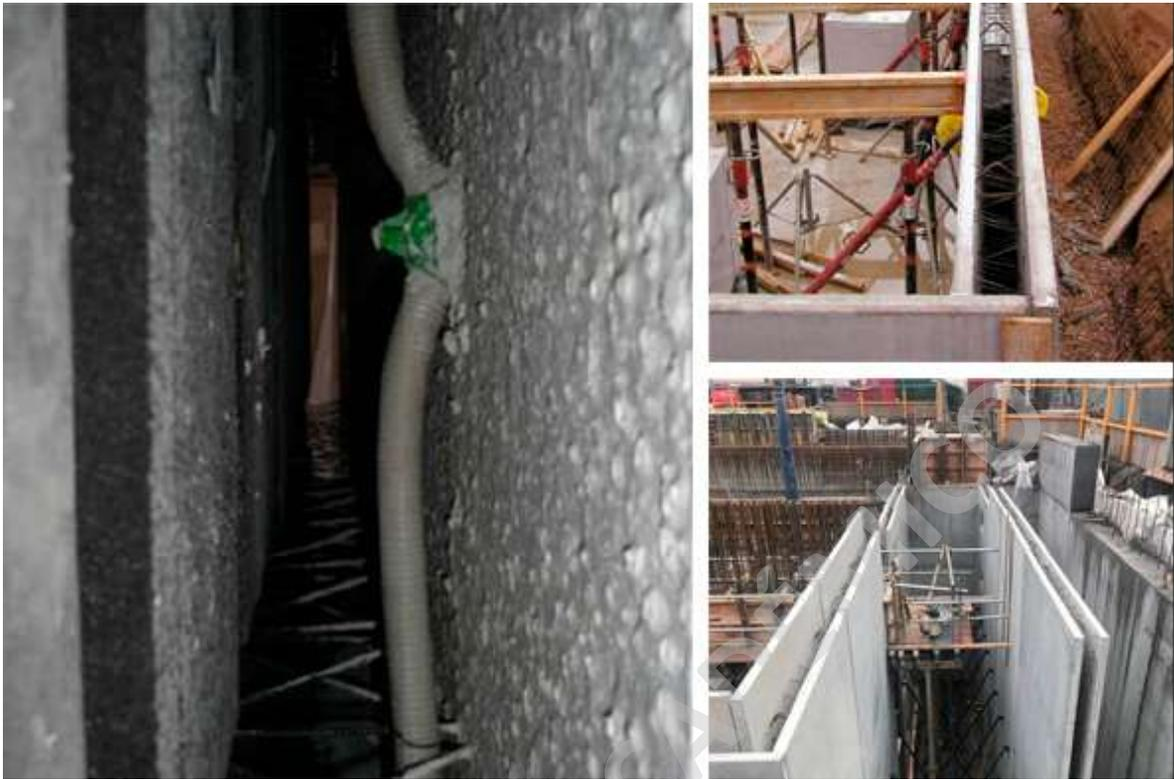
**Figura 33 - Muro doble con instalaciones interiores y en obra - fuente Valenzuela (2018) y Keegan precast.**
