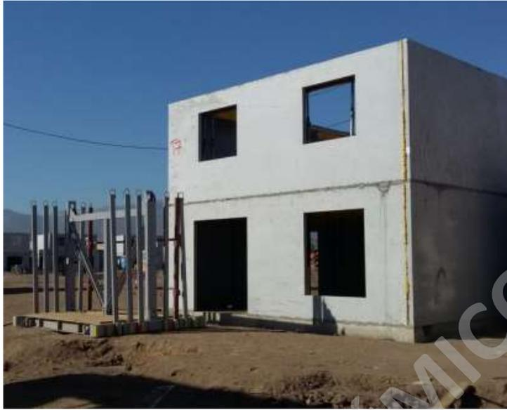
Figura 26 - Instalación de paneles, fuente Baumax.
