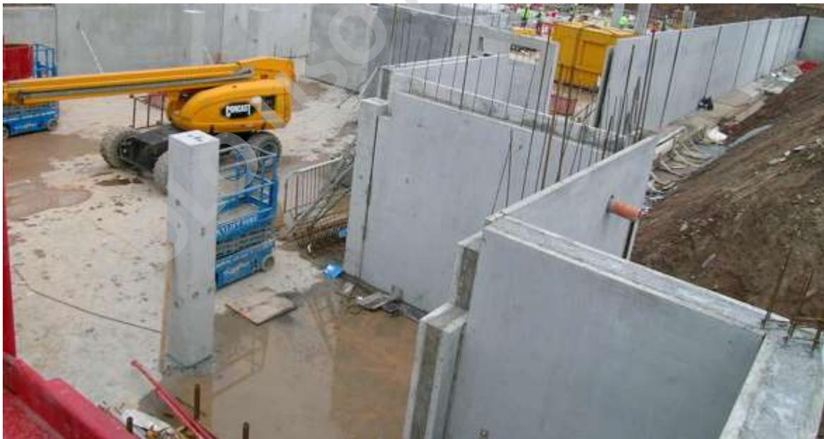
**Figura 34 - Muro doble con parte central hormigonada, fuente Archiexpo.**
