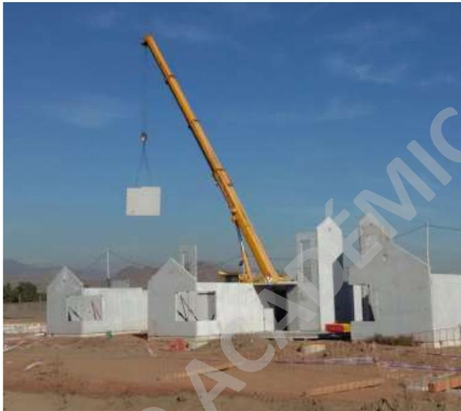
Figura 24 - Instalación de paneles, fuente Baumax.
