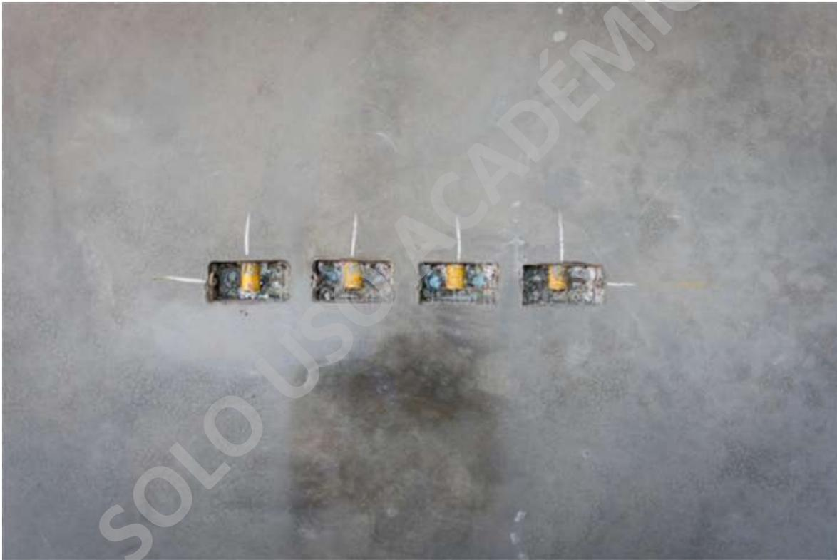
Figura 40 - Instalaciones eléctricas en muro de hormigón prefabricado - fuente Keegan precast.
