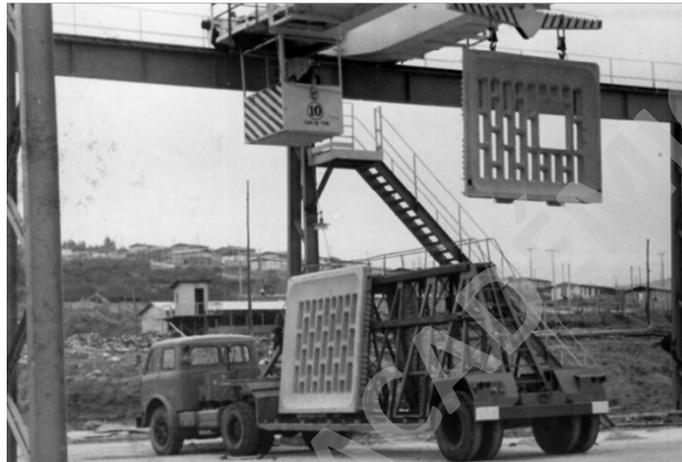
**Figura 10 - Carga de paneles Típicos KPD - El Belloto, fuente [https://wiki.ead.pucv.cl/Conjuntos\\_Habitacionales\\_KPD,\\_V\\_Región](https://wiki.ead.pucv.cl/Conjuntos_Habitacionales_KPD,_V_Región)**
