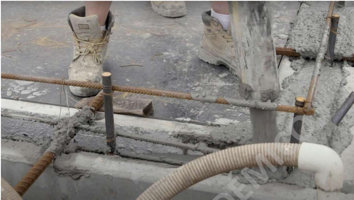
**Figura 36 - Vertido de hormigón en muro doble, fuente prefabricados Austral Precast.**
