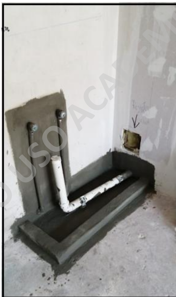
Imagen N° 26: Mejora Constructiva, Grada Buque Bajo Cocina
