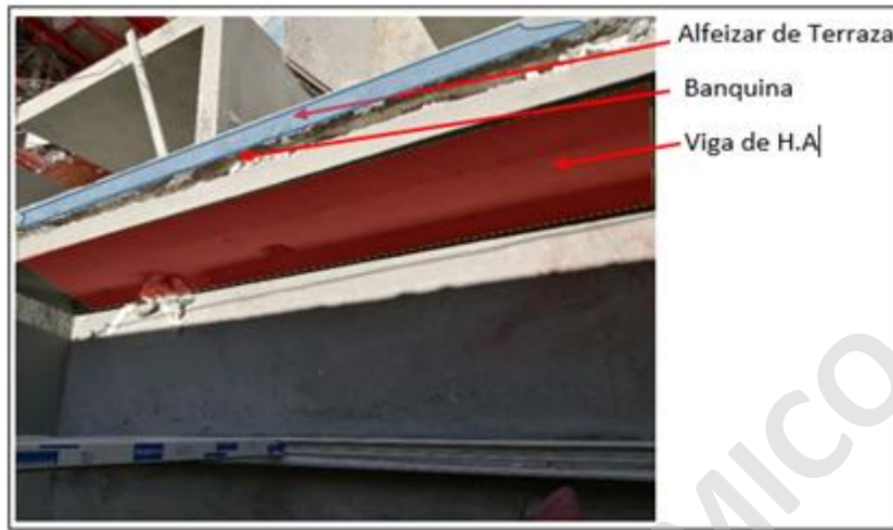
Imagen N° 21: Descripción de Solución de una Viga
