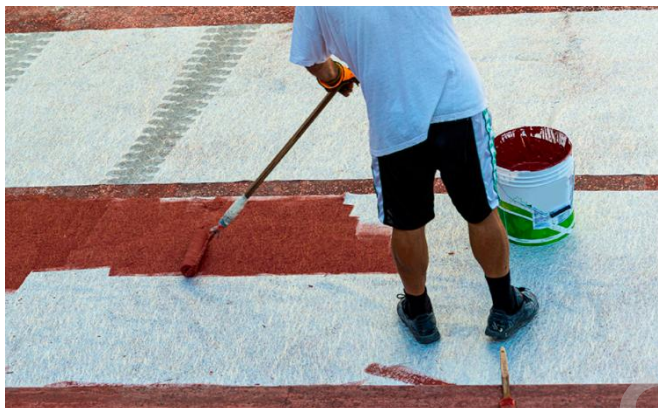
Imagen N° 6: Impermeabilización Polimérica Acrílica
