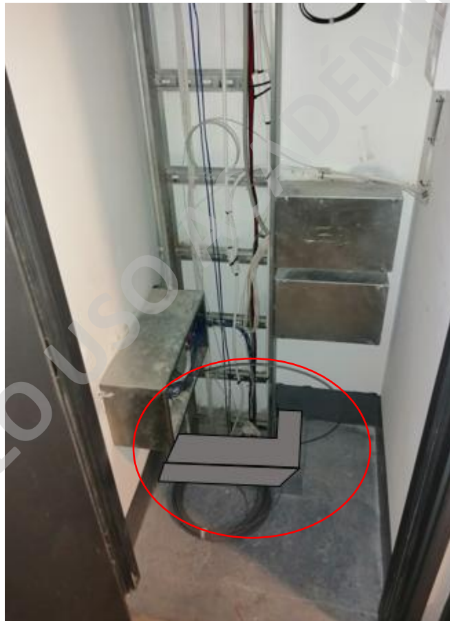
Imagen N° 27: Mejora Constructiva, Grada Buque en Nicho Corrientes Débiles
