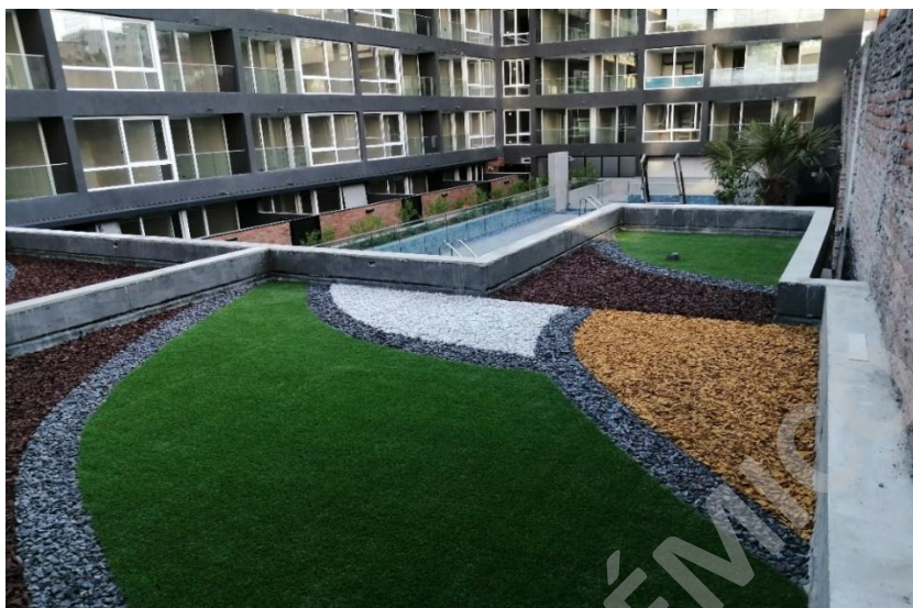
Imagen N° 23: Cubierta Verde en Sala de Eventos (sin riego)
