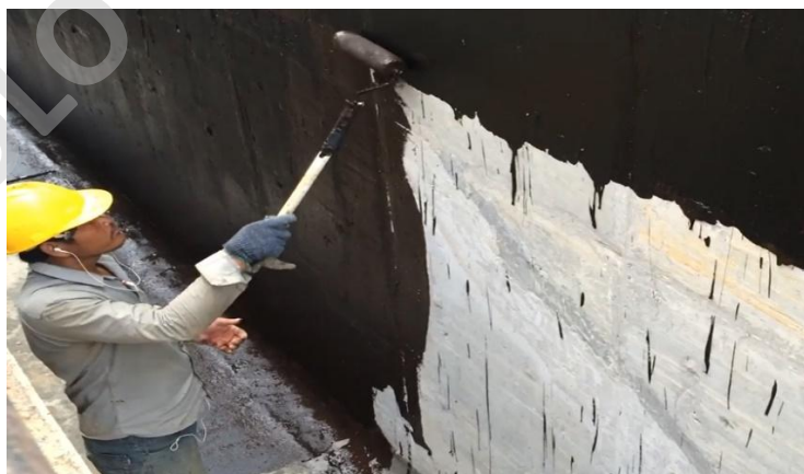
Imagen N° 7: Impermeabilización Pasta o Emulsión bituminosa
