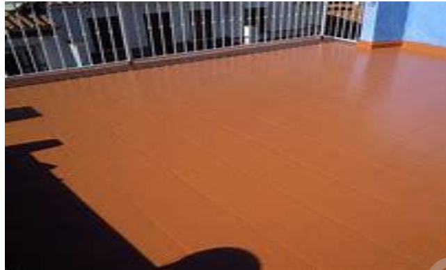
Imagen N° 5: Membrana de Poliuretano, sobre piso cerámico
