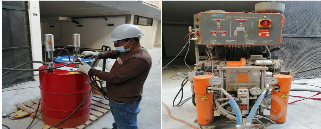
Imagen N° 9: Impermeabilización a Base de Poliurea
