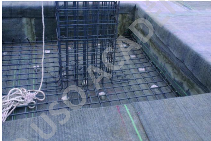
Imagen N° 14: Membrana de Bentonita
