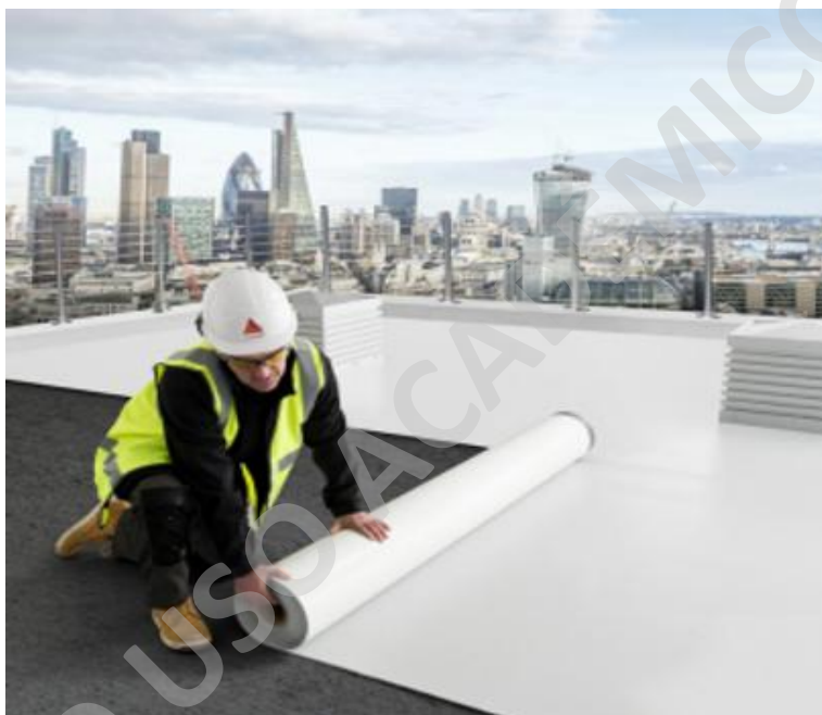
Imagen N° 4: Membrana de PVC
