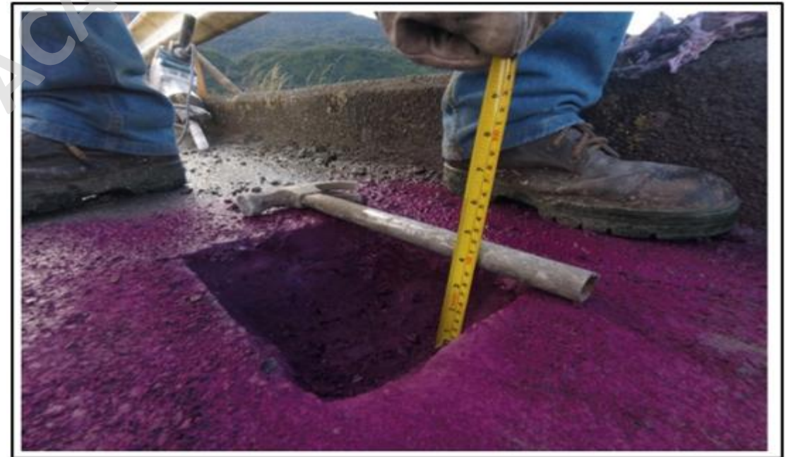
Ensayo Carbonatación Tablero del Puente Yelcho
