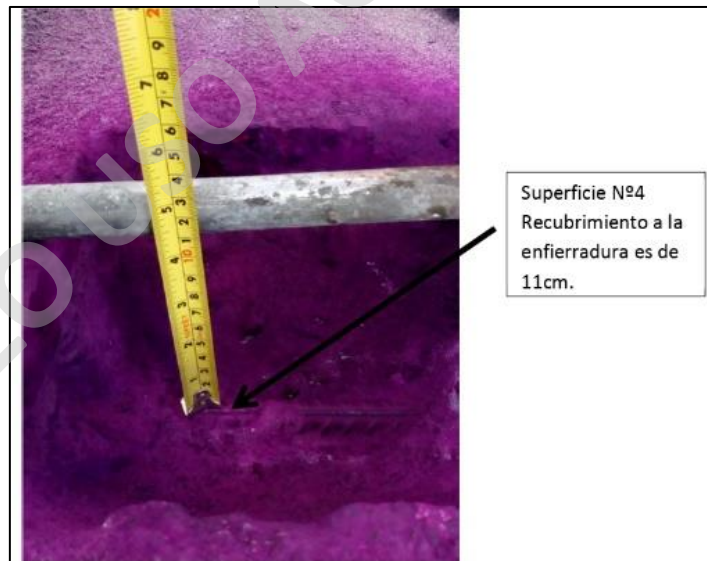
Imagen N° 31: Ensayo de Carbonatación en losa
