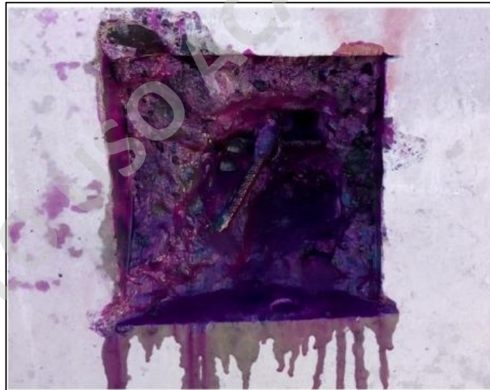
Imagen N.º 33: Ensayo de Carbonatación Sector Sur
