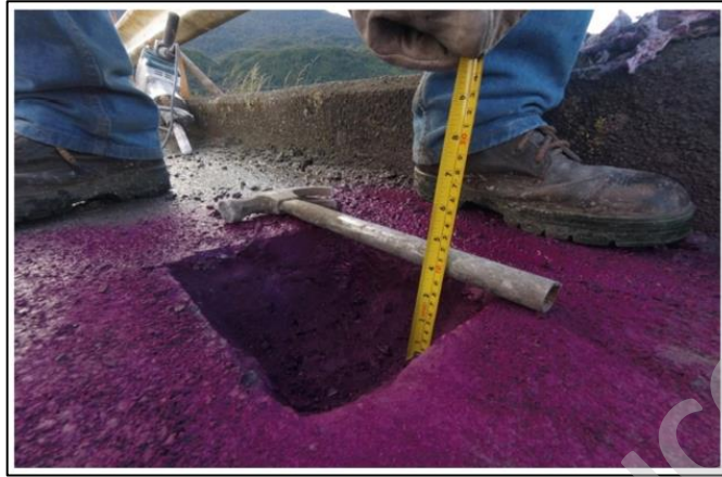
Imagen N.º 32: Ensayo Carbonatación Tablero del Puente Yelcho
