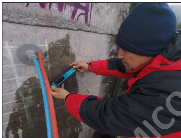
Imagen N.º 53: Mediciones de resistividad al Puente Yelcho.
