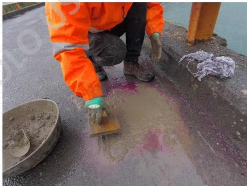
Imagen N.º 48: Ejecución de la reparación a perforación realizada al tablero del Puente.
