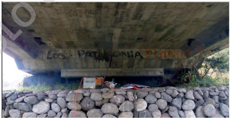
Imagen N.º 28: Ensayo Permeabilidad Tablero parte inferior Puente Yelcho
