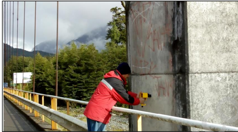
Imagen N.º 51: Medición de resistencia a la Penetración Torre sur Puente Yelcho.
