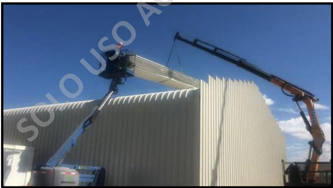
Figura N°89 - Instalación de Kover de ODR Ingeniería y Montaje.
