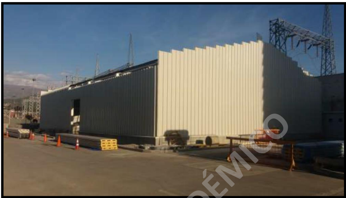
Figura N°88 - Instalación de Kover de ODR Ingeniería y Montaje.
