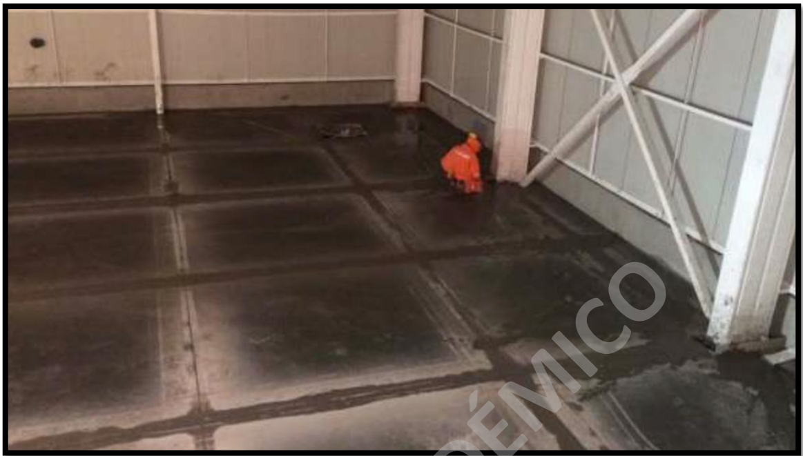
Figura N°86 – Proyecto de Mostazal ODR Ingeniería y Montaje.
