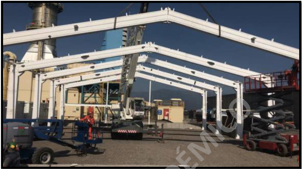
Figura N°64 - Proyecto Mostazal de ODR Ingeniería y Montajes
