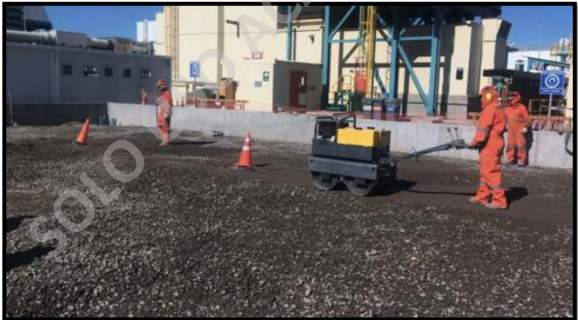
Figura N°85 – Proyecto de Mostazal ODR Ingeniería y Montaje.
