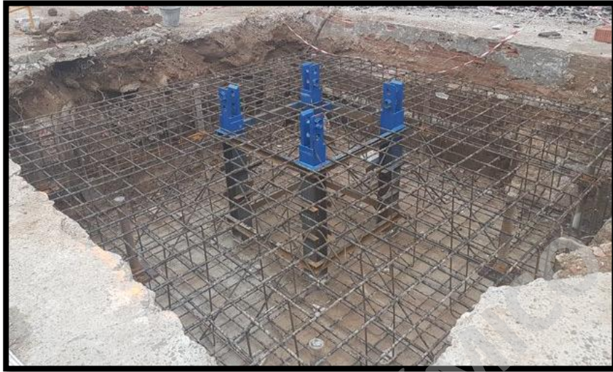
Imagen N°6: Tramo de Empotramiento - Grúa Torre Comansa.
