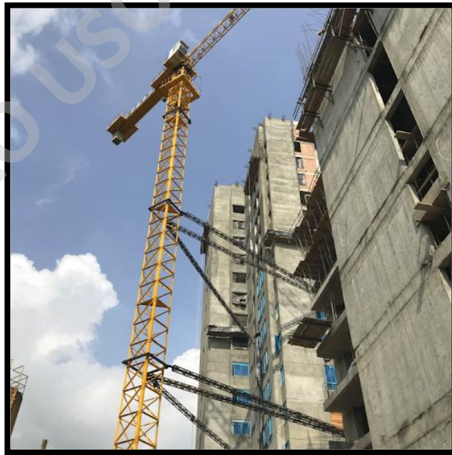
Imagen N°25: Arriostramiento a Edificio – Grúa Torre.
