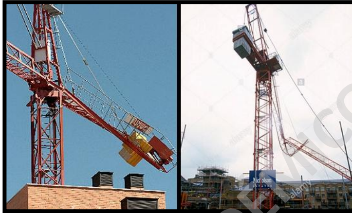
Imagen N°45: Daño Estructural de Pluma – Grúa Torre.
