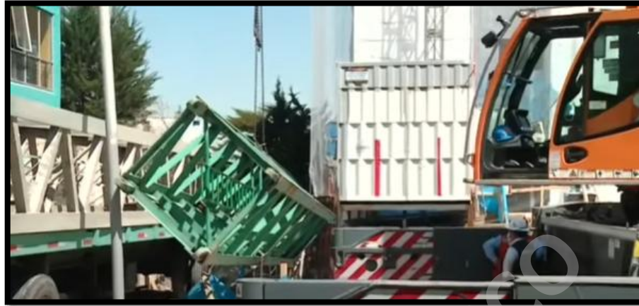
Imagen N°62: Caída Tramo Grúa Torre – Accidente fatal.
