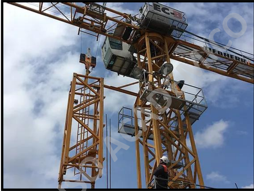
Imagen N°26: Telescopaje de Grúa Torre – Liebherr 85EC-B 5 FR Trónic.
