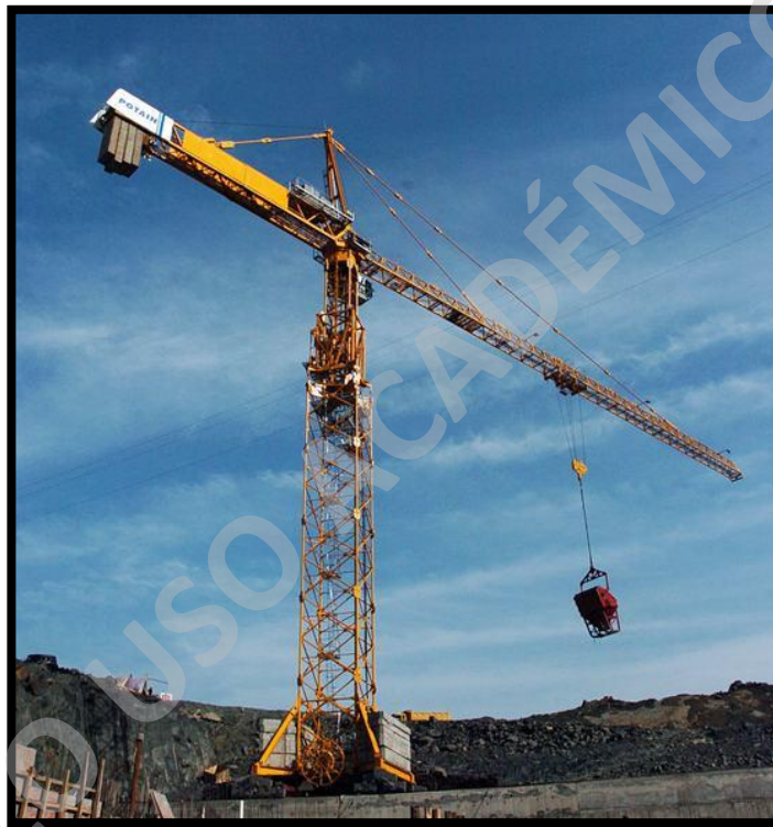
Imagen N°56: Carga en Suspensión – Grúa Torre.
