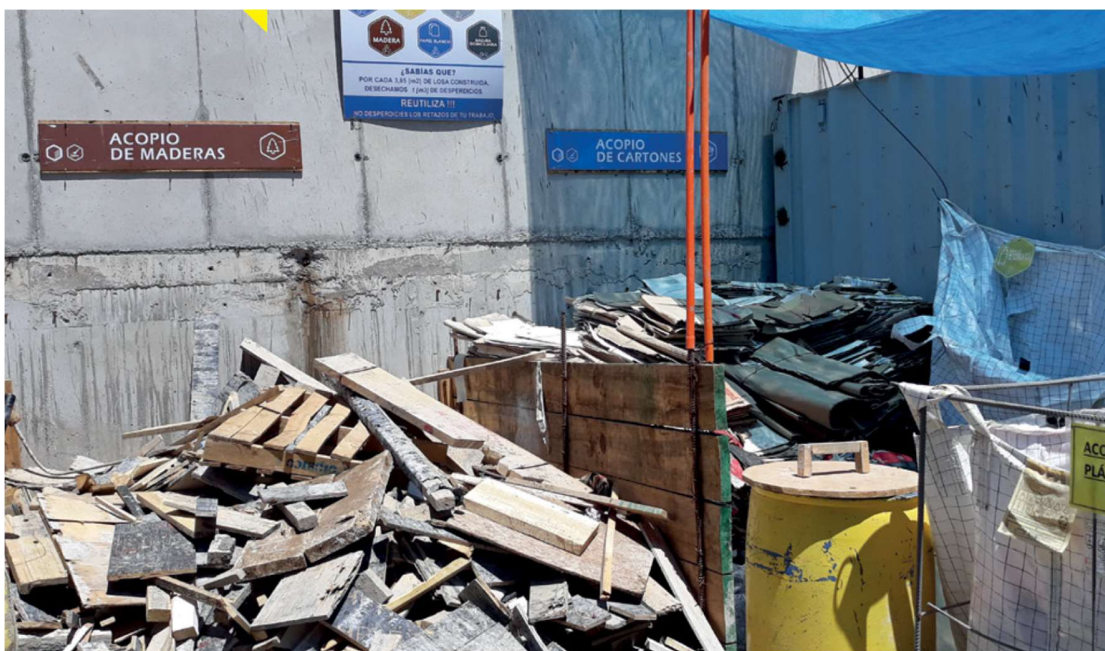
Imagen N° 4: Segregación en origen: materiales separado para posterior retiro.
