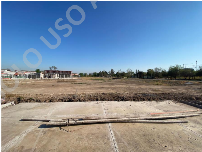
Sector sur de la laguna, sobre el radier para estructura de “Mega Juego”
