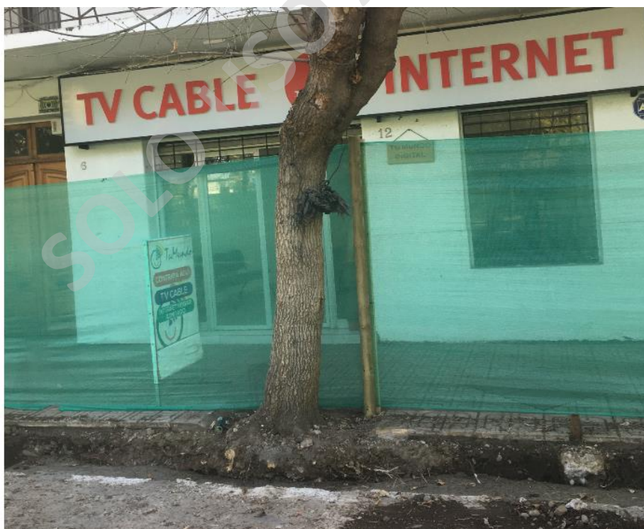
Imagen N° 41: Daño en vereda en baldosas
