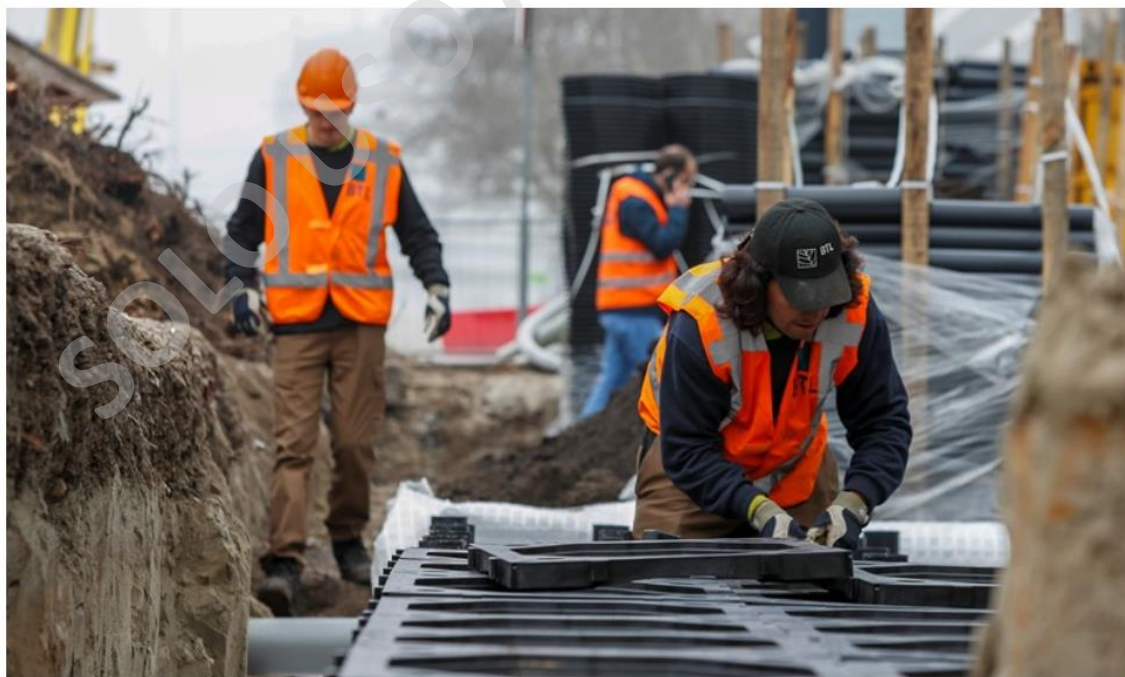
Imagen N° 12: Instalación celdas RootSpace
