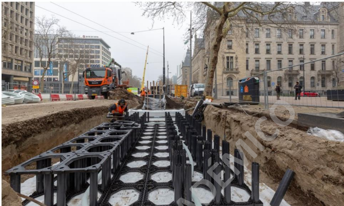
Imagen N° 11: Instalación celdas RootSpace
