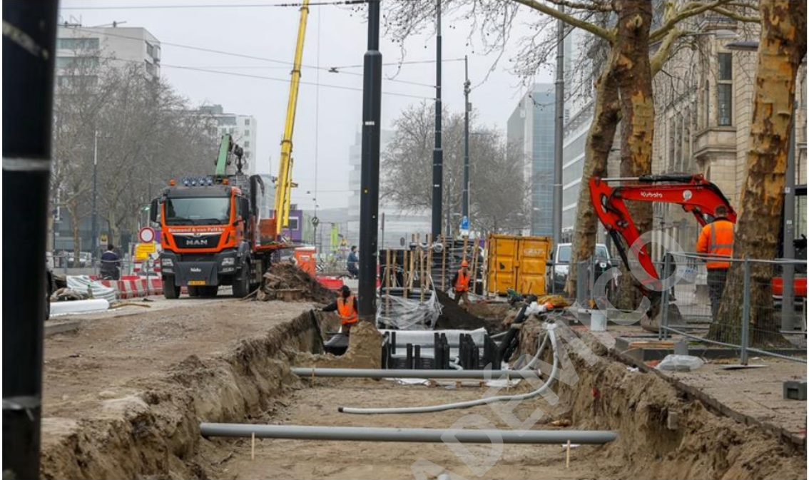
Imagen N° 15: Instalación celdas RootSpace
