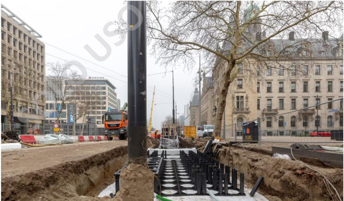
Imagen N° 18: Instalación celdas RootSpace
