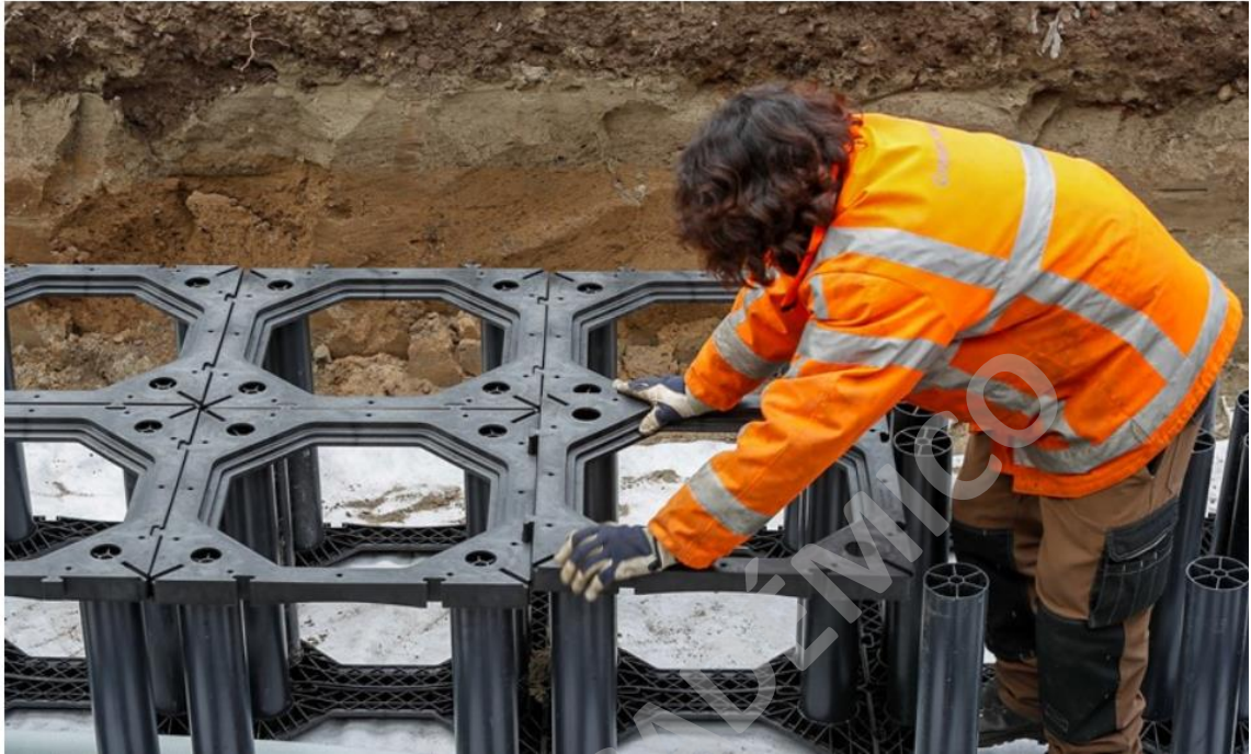
Imagen N° 13: Instalación celdas RootSpace
