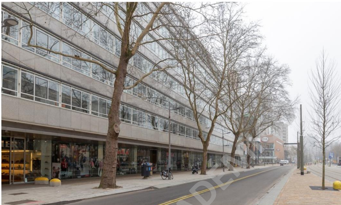
Imagen N° 19: Vista trabajo finalizado
