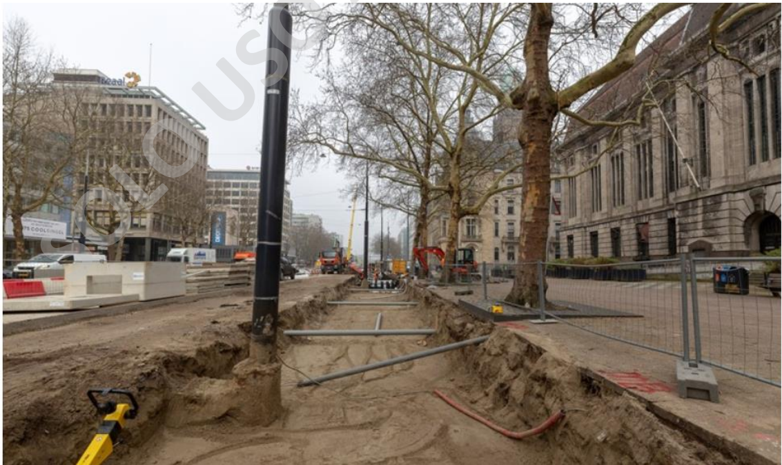
Imagen N° 14: Instalación celdas RootSpace
