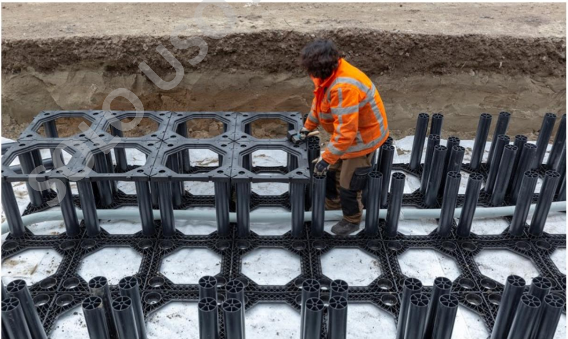
Imagen N° 16: Instalación celdas RootSpace
