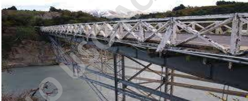
Ilustración 42, Puente Bailey en Nueva Zelanda.
