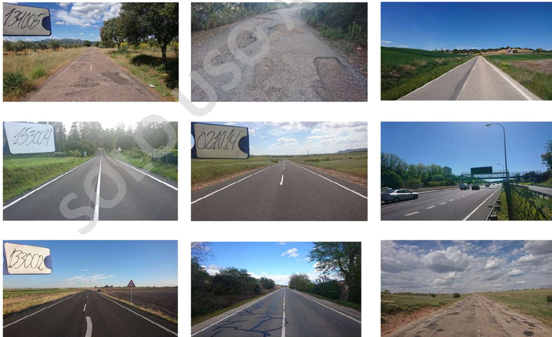
Ilustración 30, Evidencia de Estado de Pavimentos en España (Fuente: Asociación Española de la Carretera).
