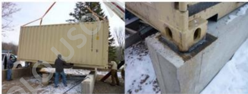
Imagen n°3: Colocación de contenedores sobre cimentación mediante suelda.
