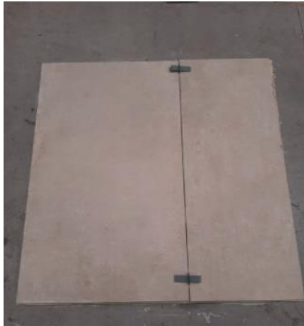
Imagen 87: Instalación revestimiento 60x120cm
