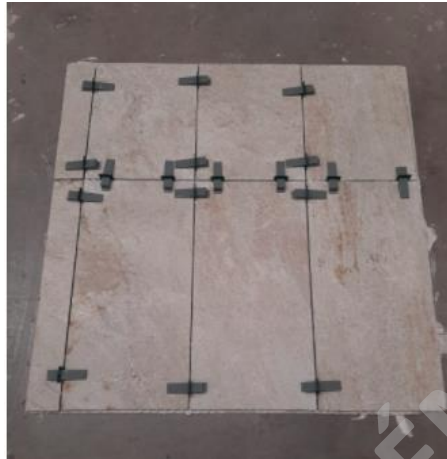
Imagen 85: Instalación revestimiento 30x60cm
