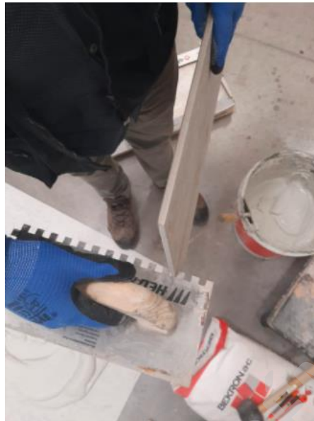
Imagen 83: Llana dentada indicada para el tipo de revestimiento.
