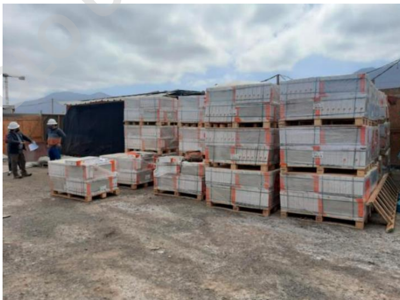
Imagen 42: Material almacenado en obra
