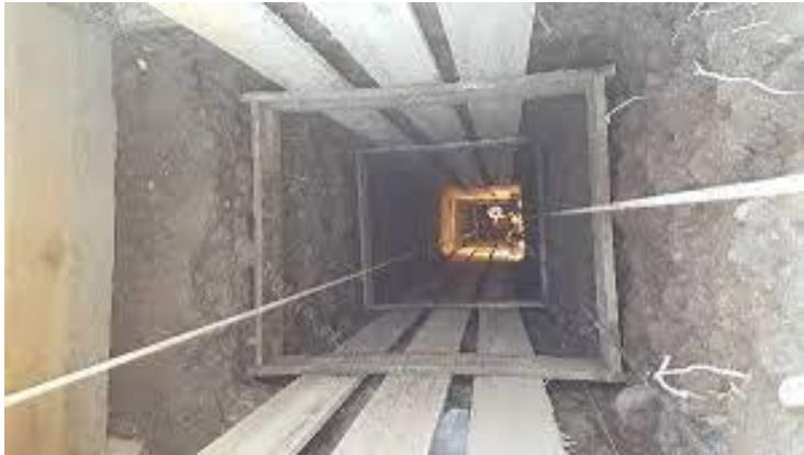
❖ Excavación Manual de Pilas de Socalzado.
