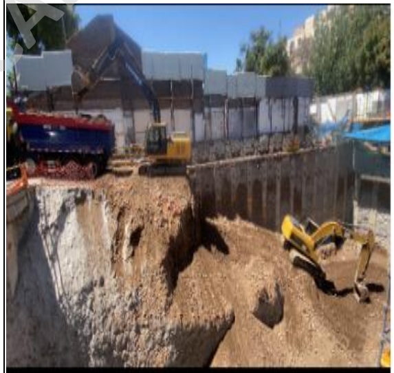
Excavación con empleo de dos Máquinas Excavadoras
