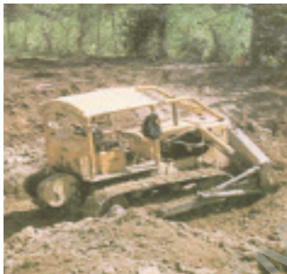
Imagen N°6: Acondicionamiento de la Superficie de Apoyo
