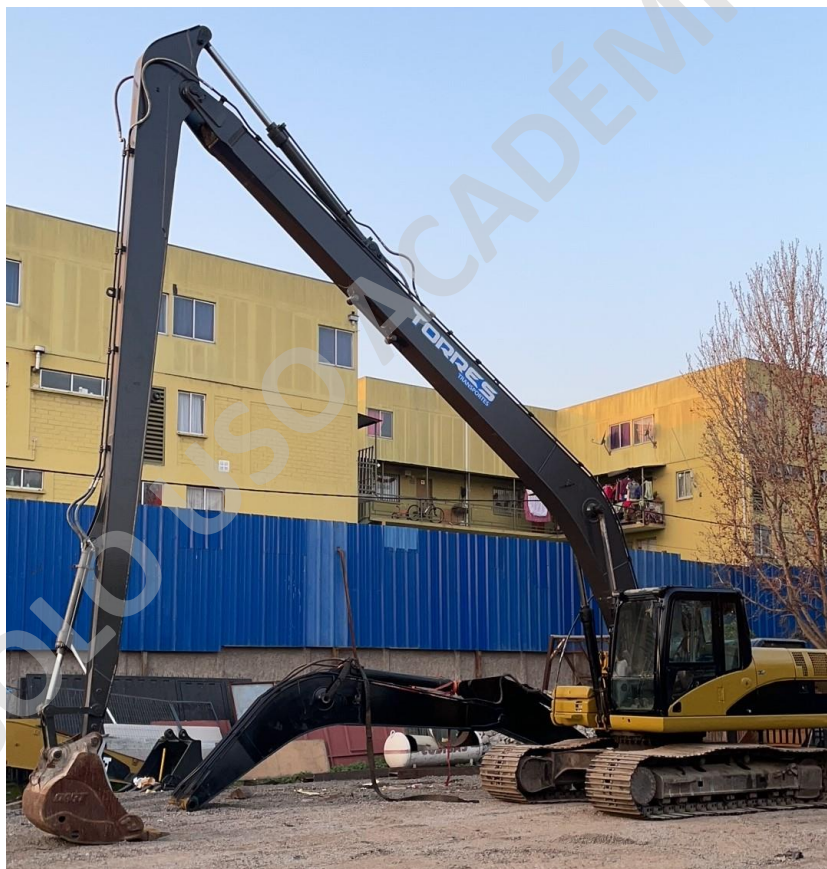
Imagen N°12: Máquina Excavadora Tipo Oruga con brazo largo.
