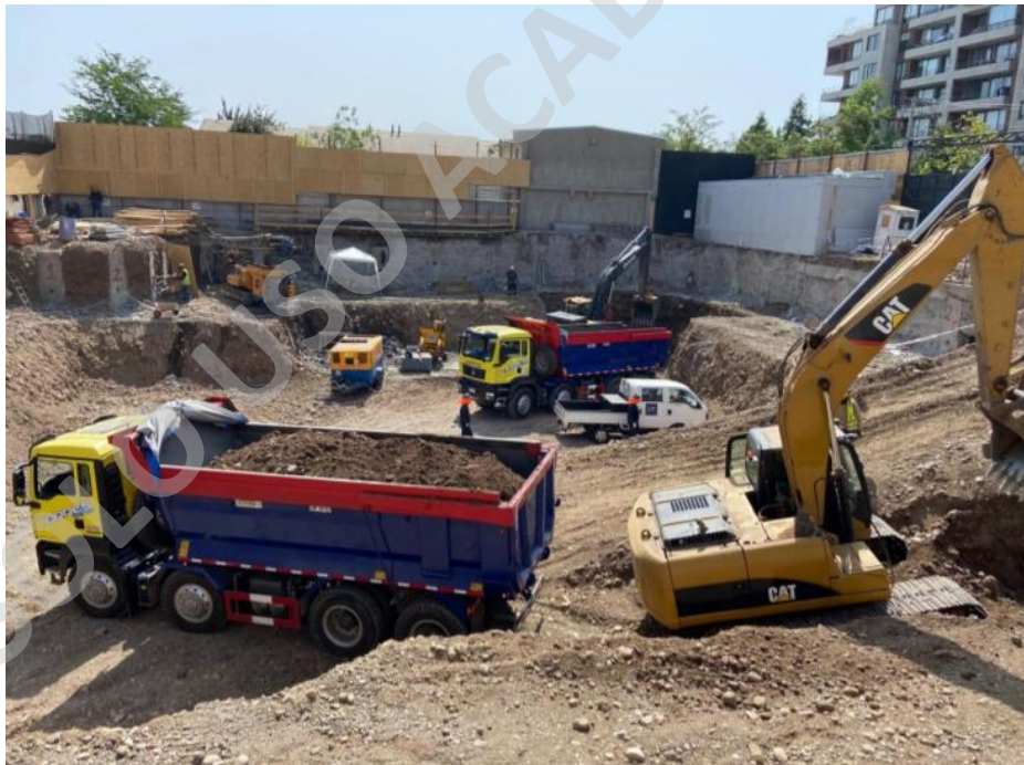
Imagen N°9: Excavación Masiva
