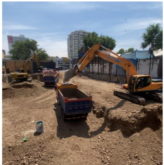
Excavación y carguío de Material proveniente de la Excavación
