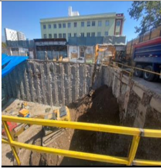
Remate de excavación con la utilización de excavadoras brazo largo
