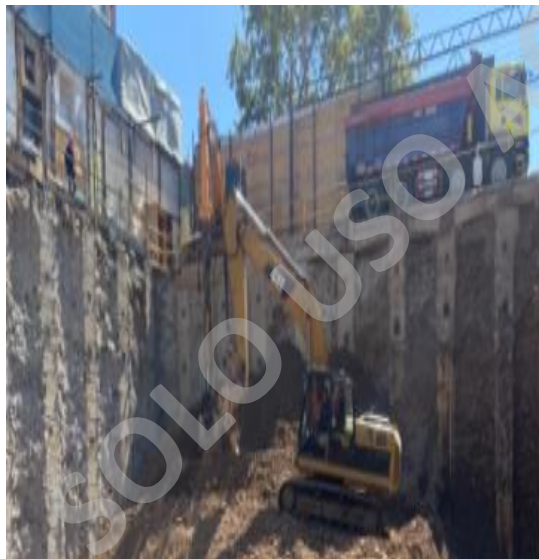
Talud para apoyo de Máquina
