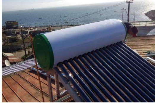
Imagen N°6: Depósito acumulador SST Heat-Pipe 150 lts.
