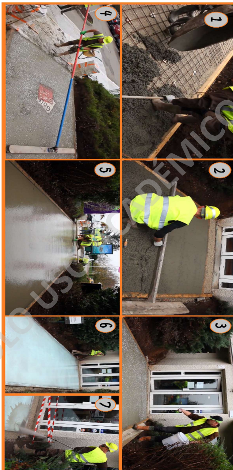
Ilustración 6: Instalación Hormigón Luminoso.
