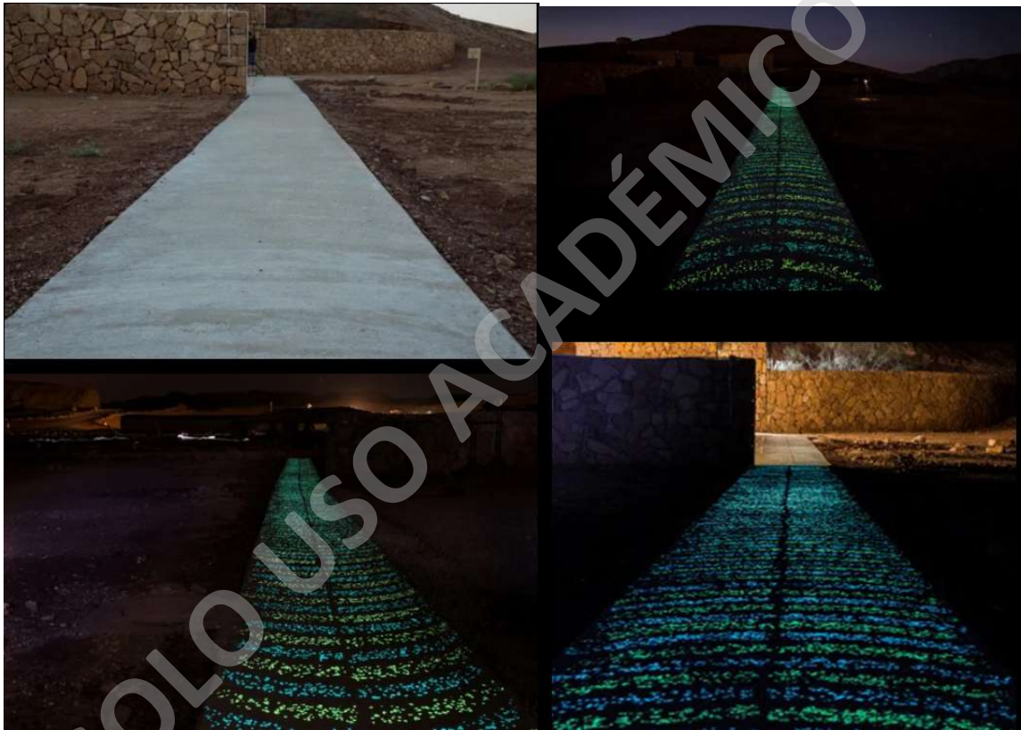
Ilustración 13: Sendero peatonal y ciclista de hormigón que brilla en la oscuridad
