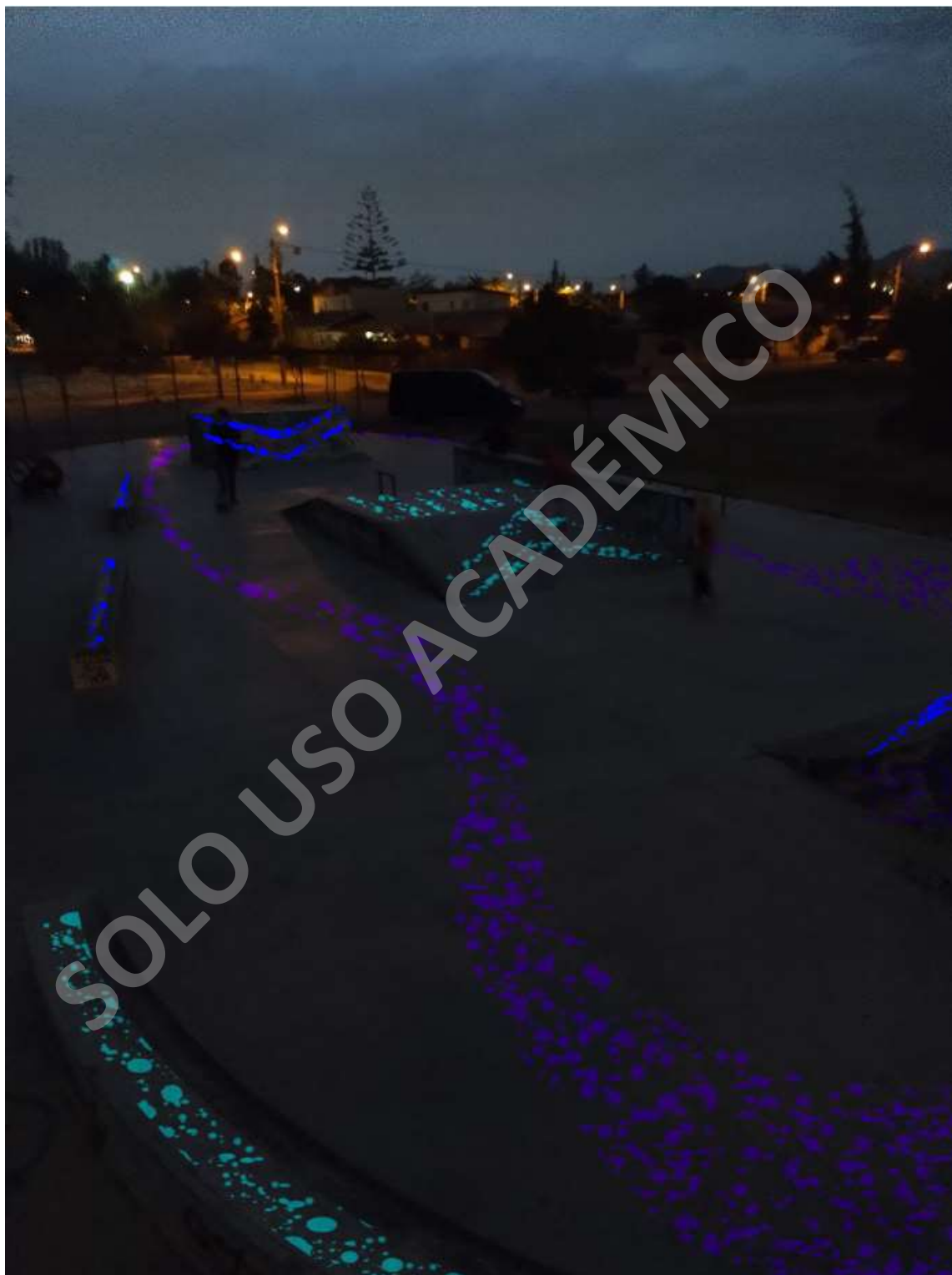
Ilustración 22: Propuesta de Skate Parck con hormigón Luminoso
