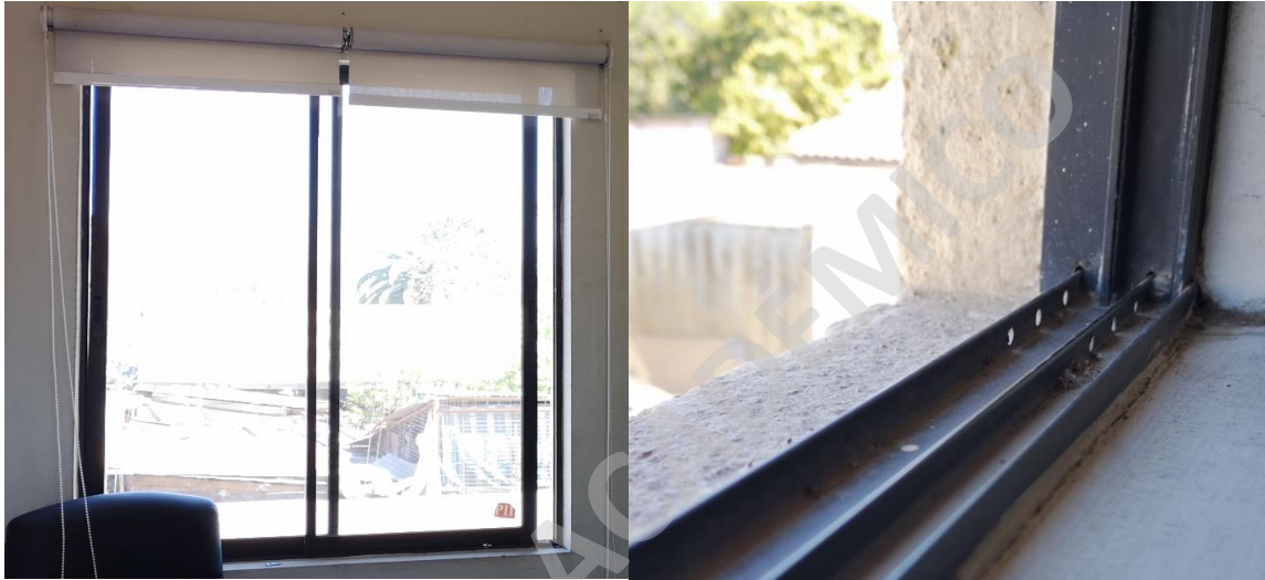
Imagen N° 75: Ventana existente, tipo corredera con marco de aluminio y cristal monolítico.
