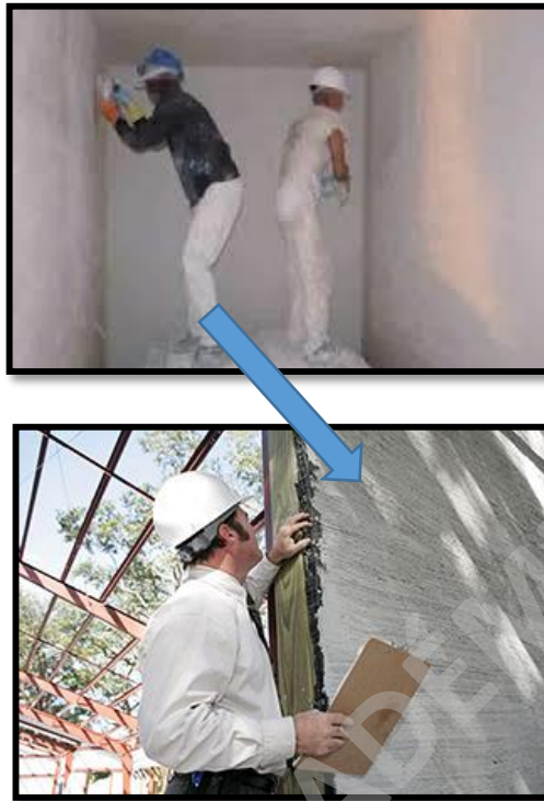
Ilustración 31: Ejecución y revisión de Yeso. Fuente: Elaboración Propia
