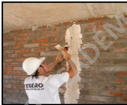
Ilustración 35: Inspección Fajas. Fuente: Recomendaciones yeso proyectado Romeral
