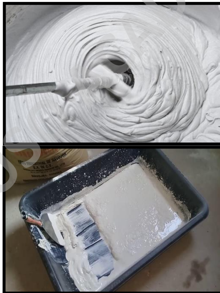
Ilustración 30: Revisión de mezclado y dosis de yeso. Fuente: Elaboración Propia
