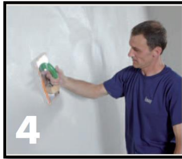
Ilustración 10: Preparación y Aplicación Yeso Proyectado. Fuente: Manual Knauf
