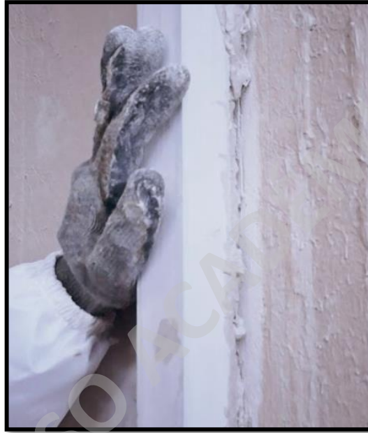
Ilustración 19: Instalación fajas – Procedimiento valido para el proyectado de Yeso. Fuente: Página Web
