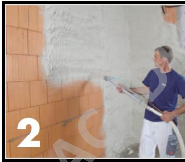
Ilustración 8: Preparación y Aplicación Yeso Proyectado. Fuente: Manual Knauf
