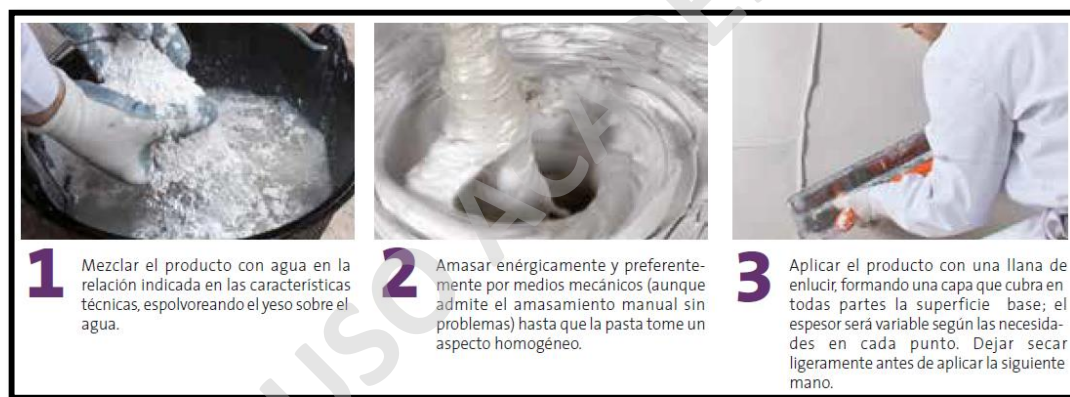
Ilustración 13: Preparación Yeso con Aditivos. Fuente: Yesos de Construcción Placo Saint-Gobain
