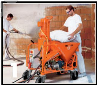
Ilustración 7: Preparación y Aplicación Yeso Proyectado. Fuente: Manual Knauf
