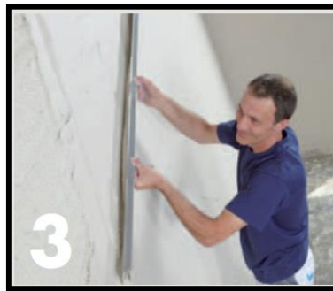
Ilustración 9: Preparación y Aplicación Yeso Proyectado. Fuente: Manual Knauf
