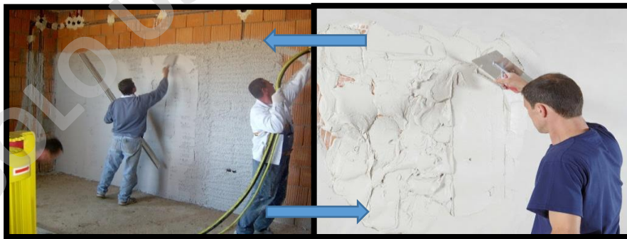
Ilustración 12: Diferencias Aplicación y Rendimiento Proceso Manual y Mecanizado. Fuente: Elaboración Propia
