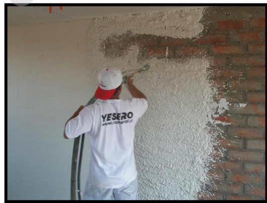
Ilustración 36: Visualización proyección en forma de abanico. Fuente: Recomendaciones yeso proyectado Romeral
