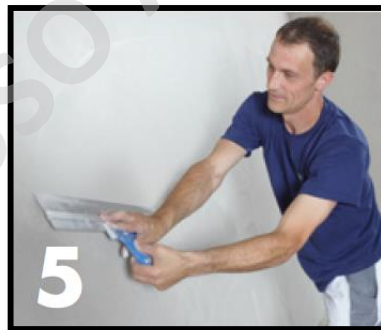
Ilustración 11: Preparación y Aplicación Yeso Proyectado. Fuente: Manual Knauf
