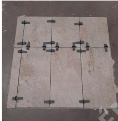
Imagen 85: Instalación revestimiento 30x60cm
