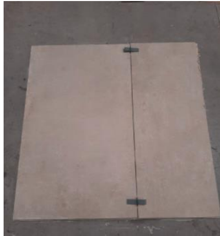
Imagen 87: Instalación revestimiento 60x120cm
