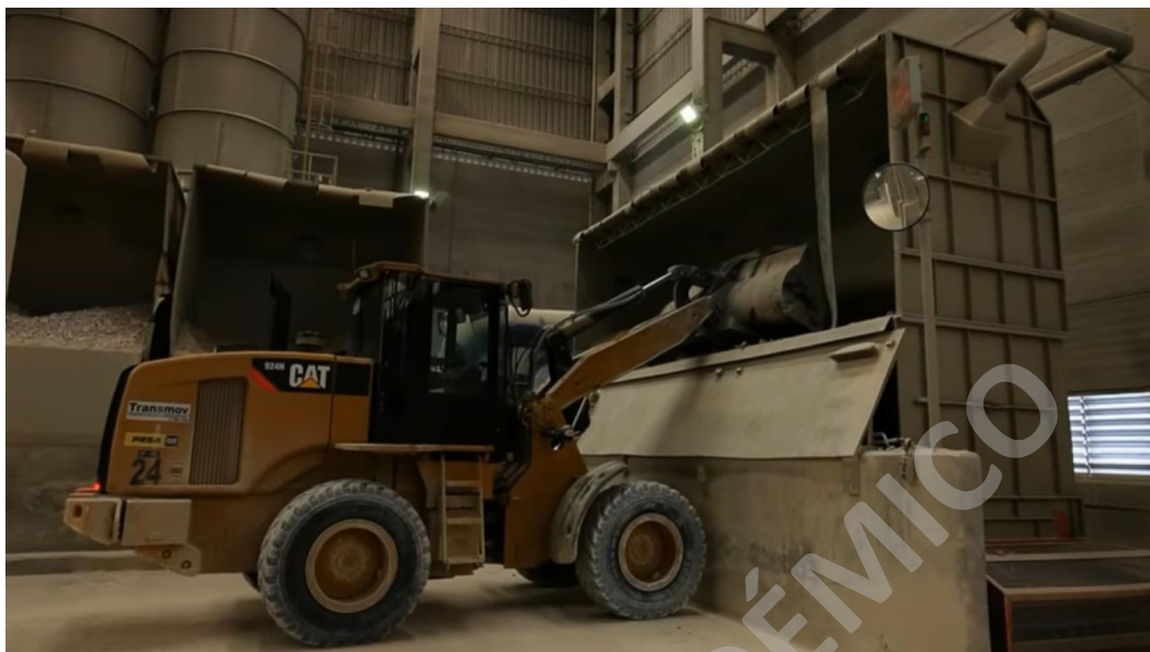
Imagen 16: Tolva cargando materia prima
