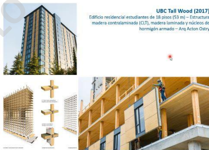
Imagen 4 Edificio en Canadá con núcleo de hormigón y estructura de madera
