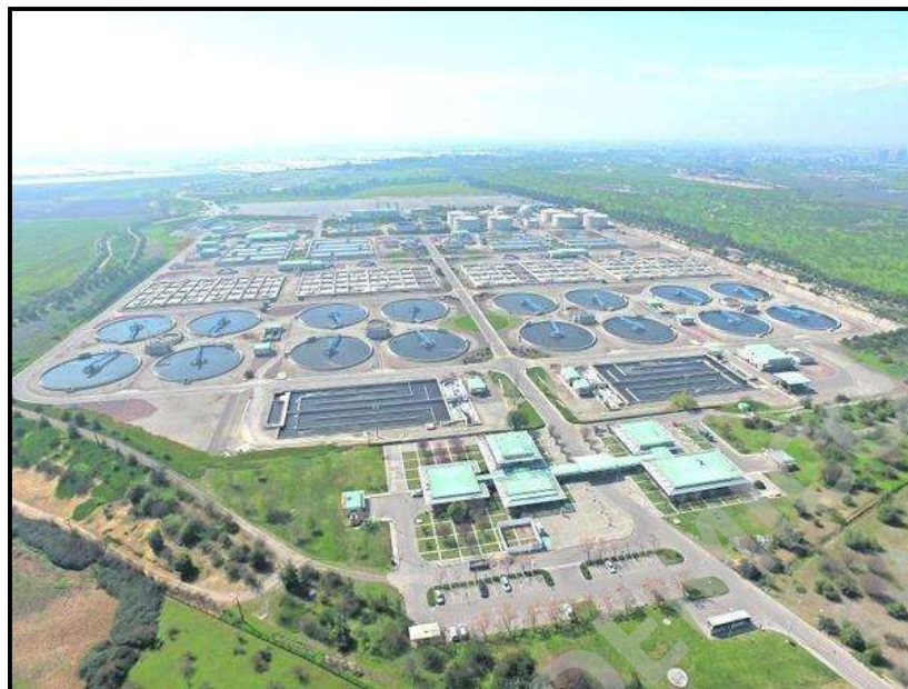
Imagen N° 1: Planta de Tratamiento La Farfana Chile
