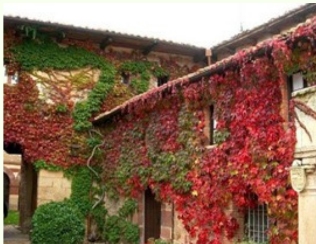
Fig. 9 Fachada tradicional fuente: https://verfachadasdecasas.com
