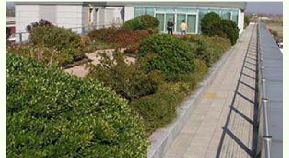
Fig. 19 Cubierta ajardinada semi intensiva fuente https://www.projar.es
