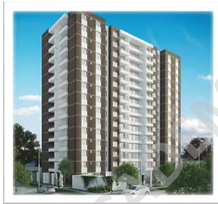
Figura 12 Edificio Manuel Montt
