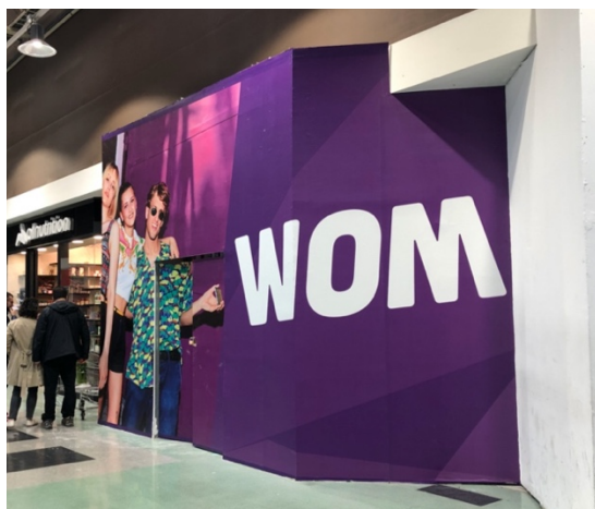
Figura 10. Manual de construcción - Cierre provisorio ejecutado. Fuente: Elaboración propia.
