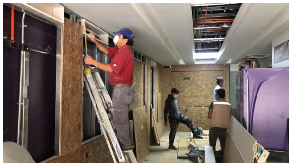
Figura 26. Sucursal Apumanque - Visita de obra. Fuente: Elaboración propia.
