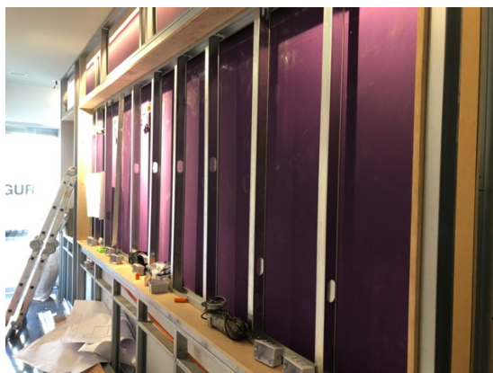
Figura 3. Sucursal Viña Echevers - Estructura tabiquería. Fuente: Elaboración propia.
