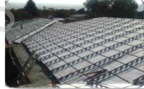
Instalación de barras de refuerzo
