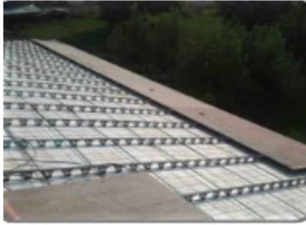
Instalación las planchas de OSB.
