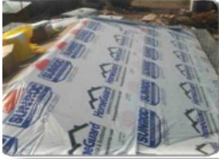
Instalación de membrana impermeable
