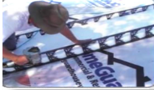
Instalación de las hileras de lazos de unión y laminas de poliestireno expandido.
