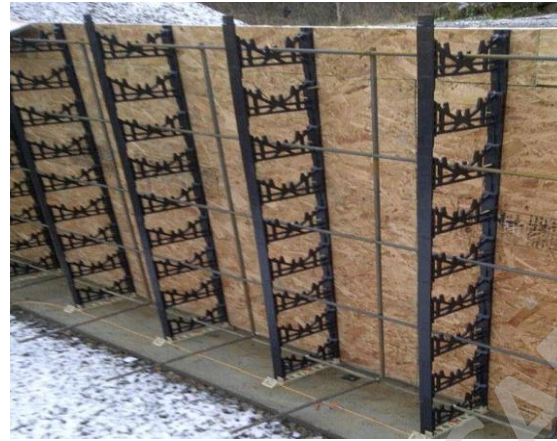
Instalación de los lazos de unión y las barras de refuerzo.
