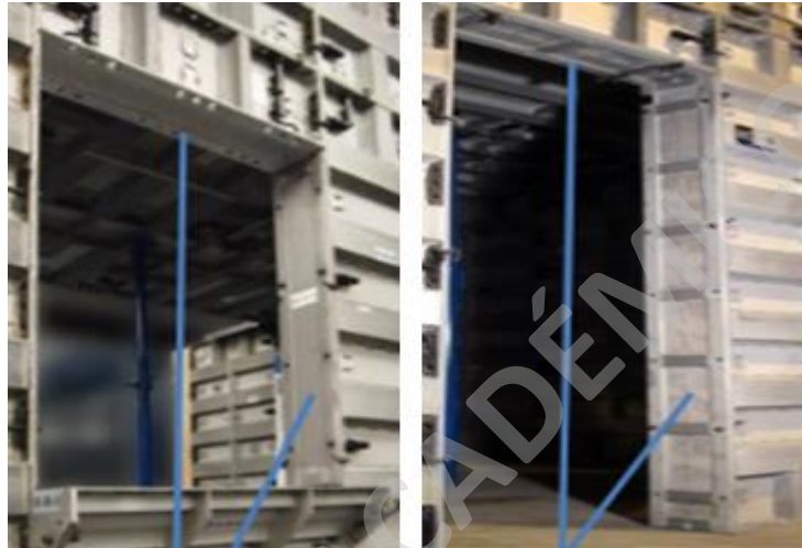
Imagen N° 22. Tapas de muros en vanos de puertas y ventanas del sistema Western Forms.
