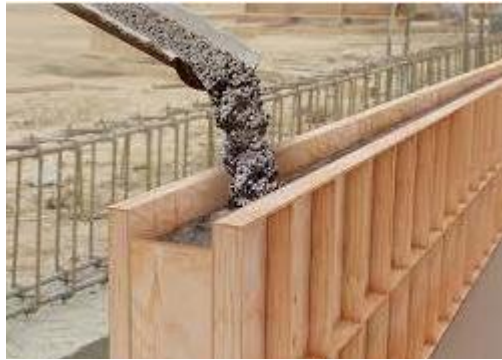
Imagen N °9. Moldaje de madera Selex.
