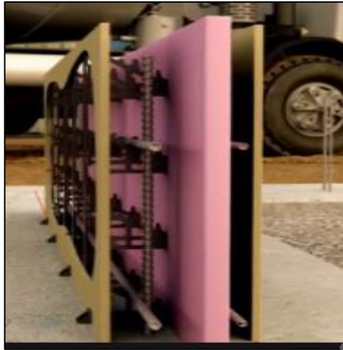
Imagen N° 16. Instalación de planchas de poliuretano expandido, dentro de muros con sistema Spider Tie.
