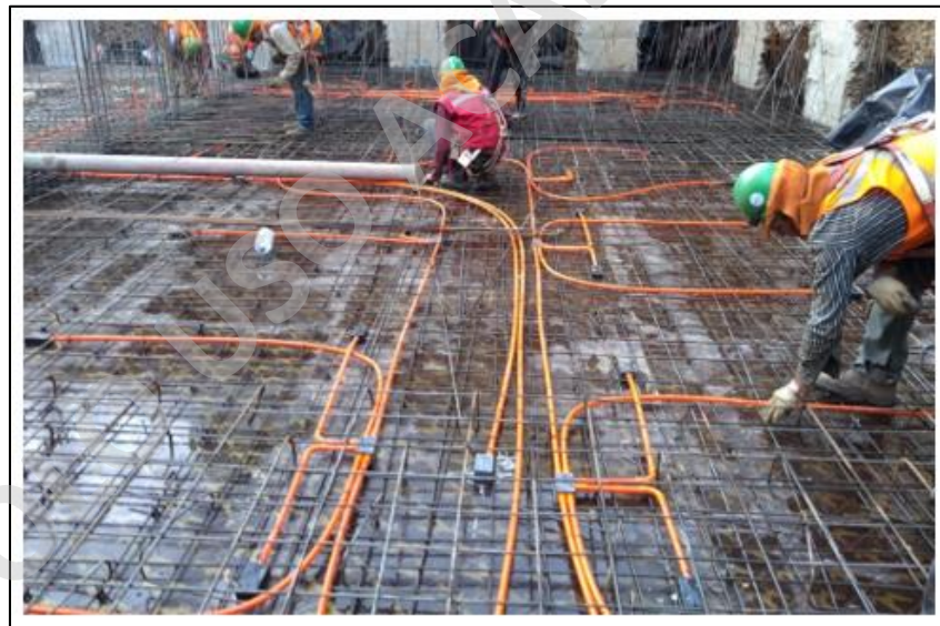
FIG. 2: Enfierraduras de losa. Obtención propia
