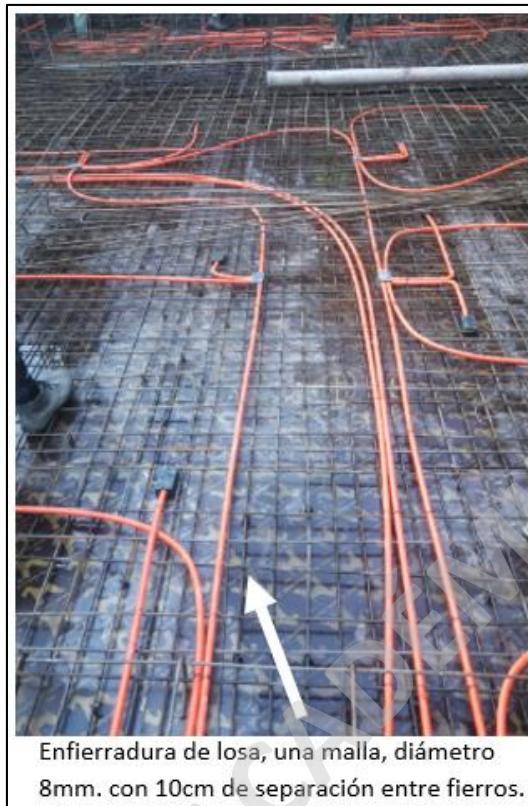
FIG. 4: Enfierraduras de losa corregida. Obtención propia
