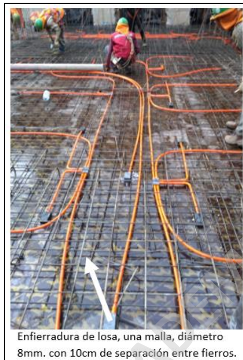
FIG. 3: Enfierraduras de losa. Obtención propia
