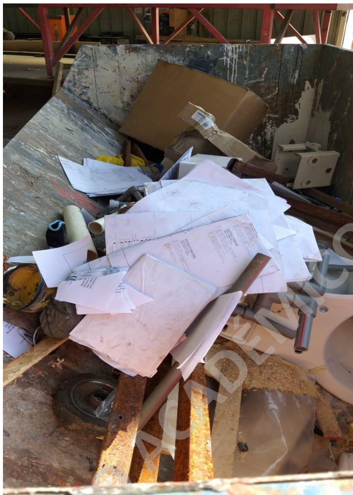
Fuente: TecnoFast (2019) Zona escombros
