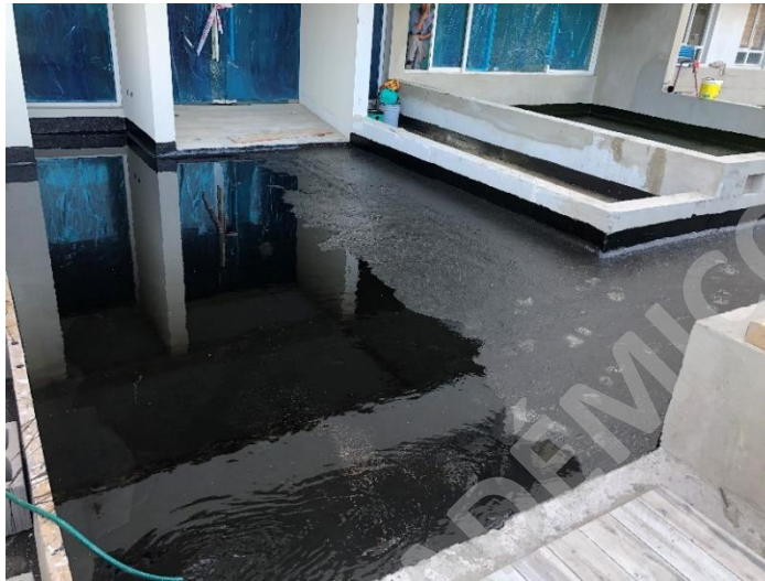
Figura 22: Prueba estanqueidad jardineras
