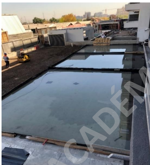
Figura 25: Impermeabilización sector tránsito vehicular
