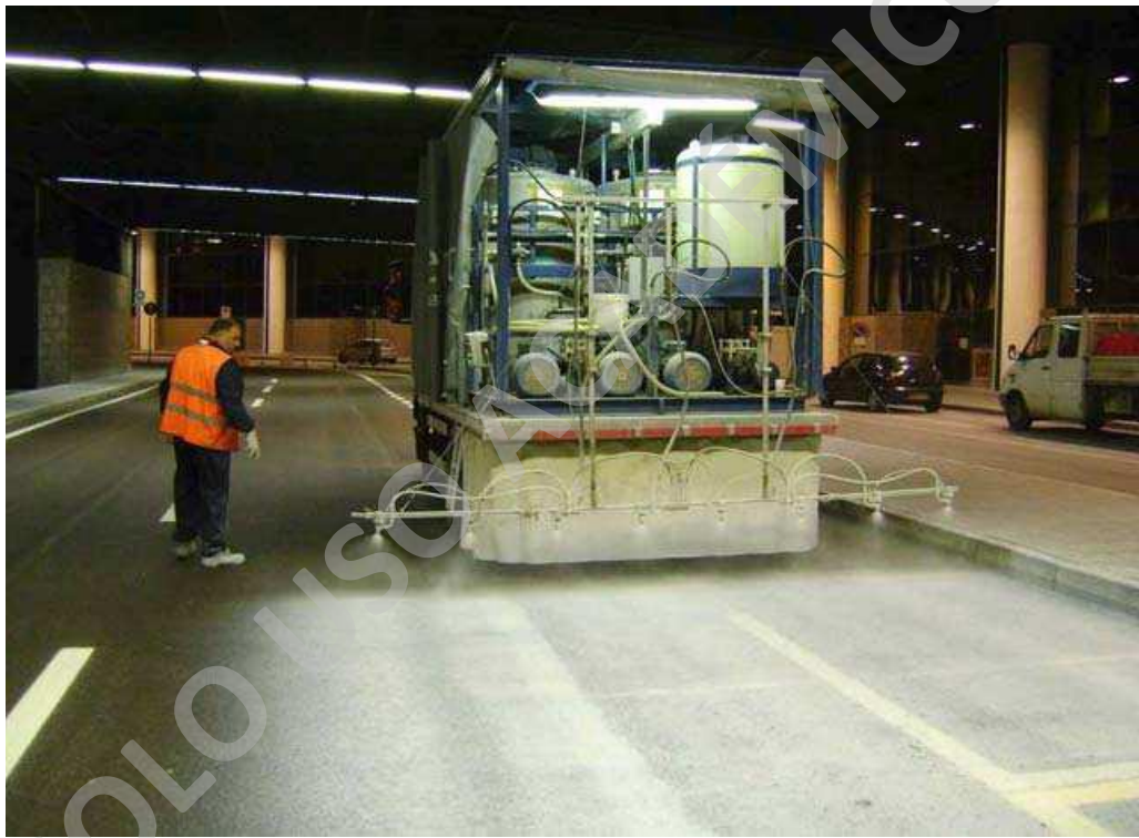
ILUSTRACIÓN 19: MÉTODO DE PULVERIZACIÓN CON CAMIÓN ESPECIALIZADO
