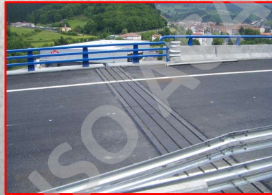
Juntas Apernadas de Neopreno Armado
