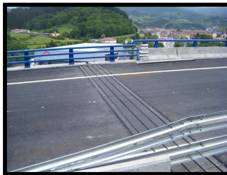
Figura 27: Junta Apernadas de Neopreno Armado. Fuente: Obtenido de Empresa Orión.
