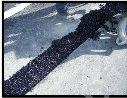
Figura 26: Junta Elástica Tipo Chicle. Fuente: Obtenido de Empresa Orión.
