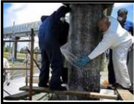
Figura 13: Instalación de Sistema TYFO con fibras de Vidrio. Fuente: Registro CDT.
