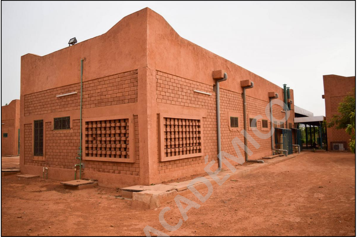
Imagen 05: Ejemplo de construcción en BTC.
