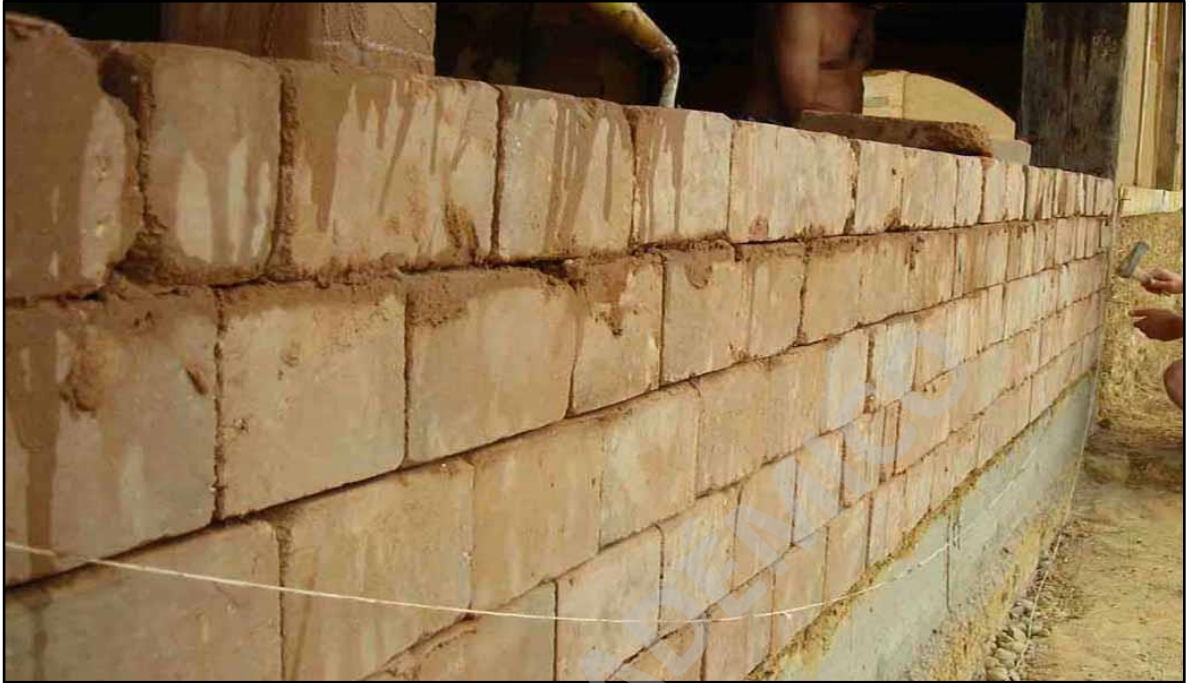
Imagen 04: Muro construido en BTC.
