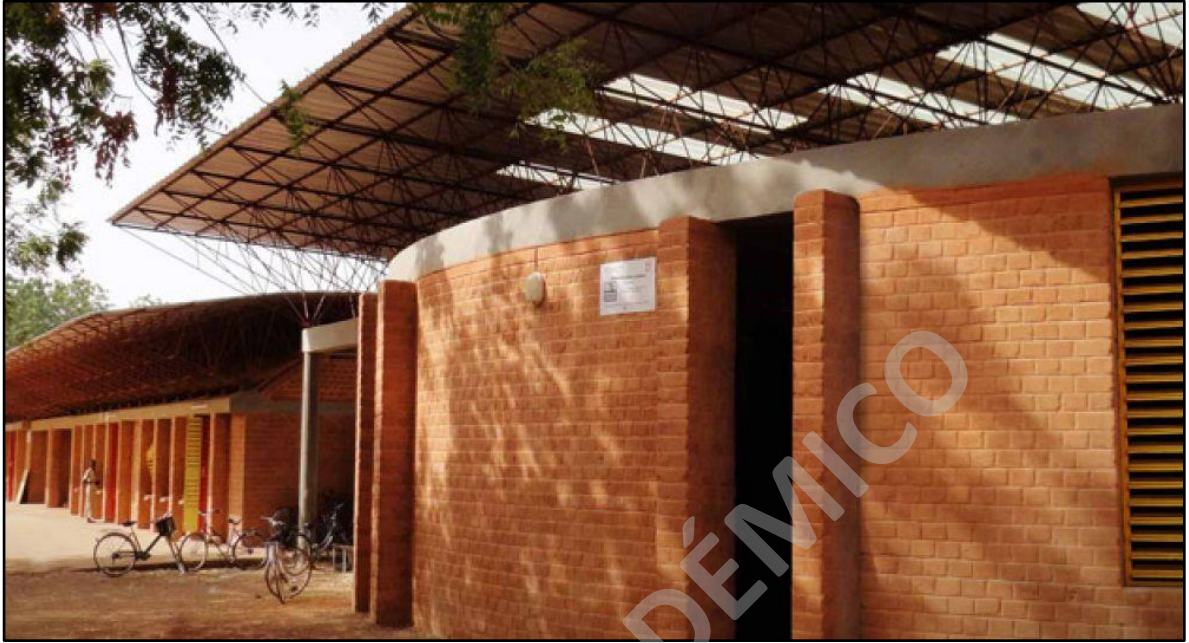
Imagen 02: Sistema de amarre y muros en BTC.
