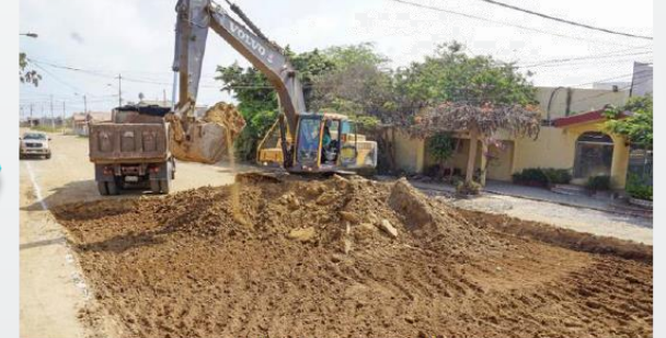
Imagen 57: Demolición y Excavación
