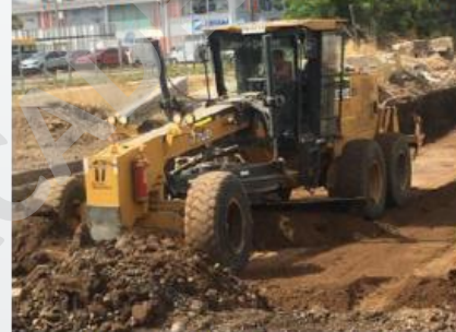
Imagen 56: Movimiento de Tierra
