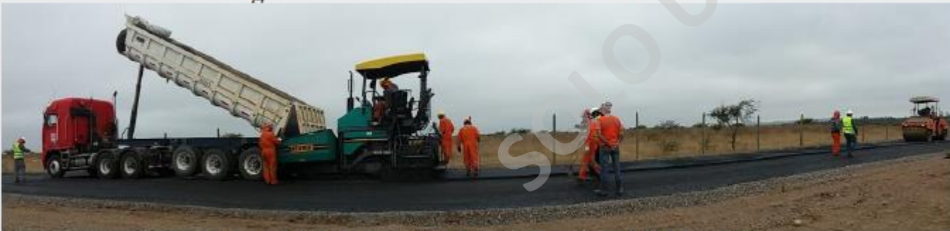
Imagen 83: Extensión de Mezcla con Terminadora
