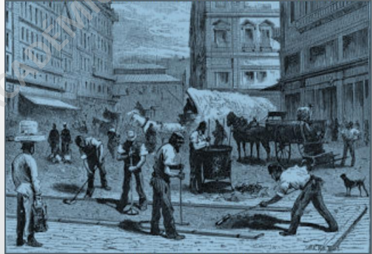
Imagen 5: Construcción de Calzada en Roca Asfáltica Calentada
