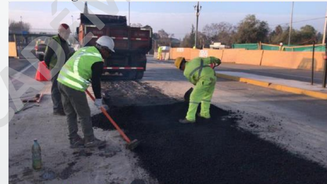
Imagen 81: Colocación de Mezcla Manual
