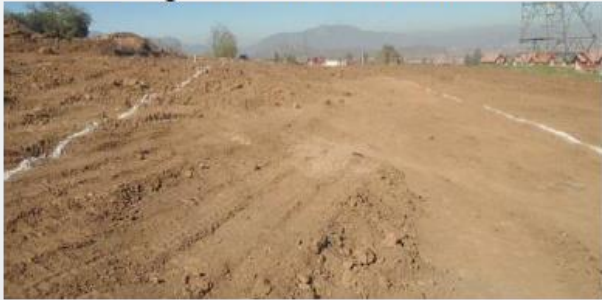
Imagen 55: Trazado de Calzada
