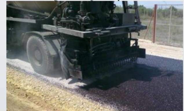
Imagen 77: Riego de Imprimación
