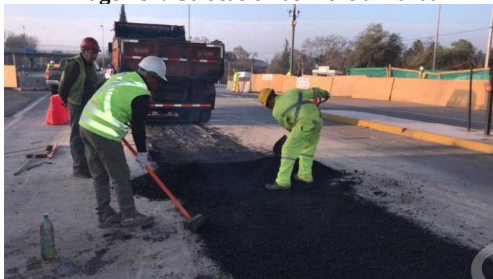
Imagen 81: Colocación de Mezcla Manual
