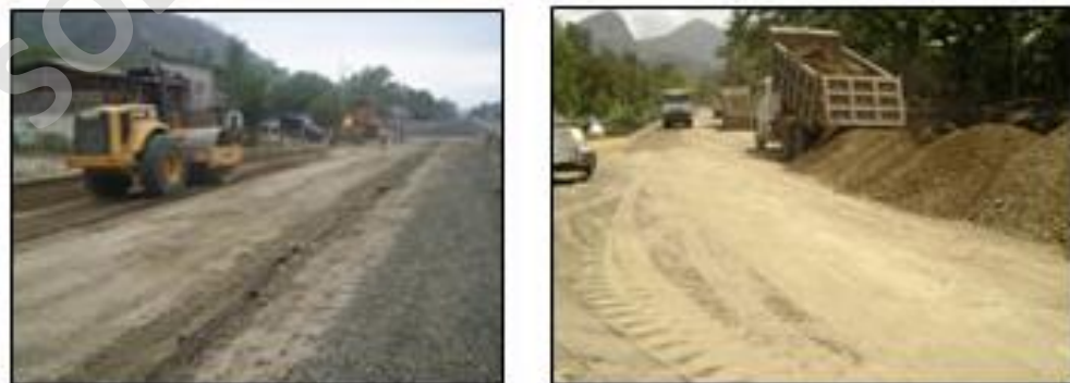
Imagen 67: Extensión de Subbase
