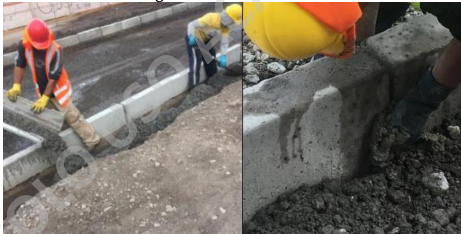
Imagen 73: Instalación de Soleras
