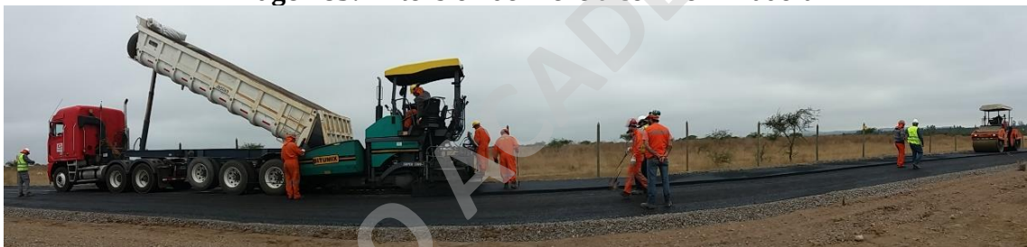
Imagen 83: Extensión de Mezcla con Terminadora
