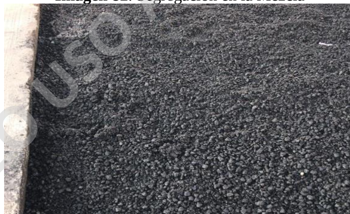
Imagen 82: Segregación en la Mezcla
