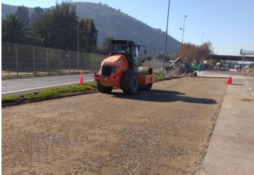
Imagen 71: Compactación de Base
