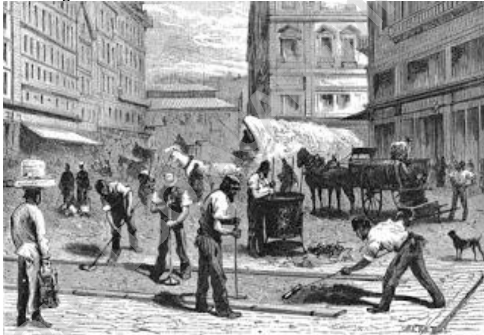
Imagen 5: Construcción de Calzada en Roca Asfáltica Calentada
