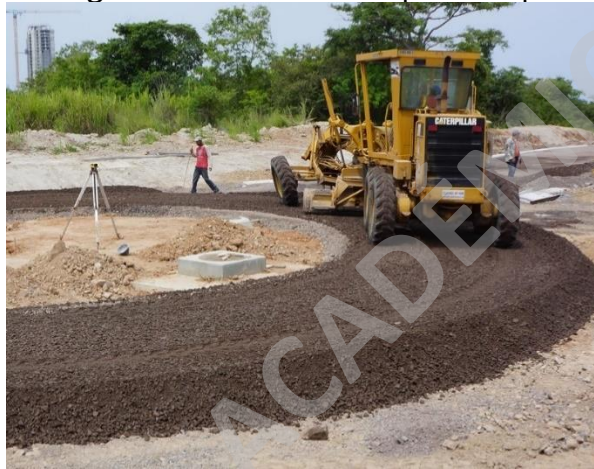
Imagen 64: Extensión de Capas Terraplén
