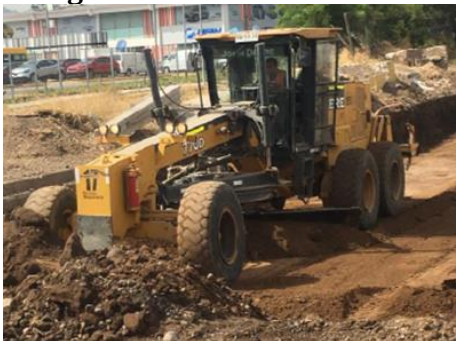
Imagen 56: Movimiento de Tierra
