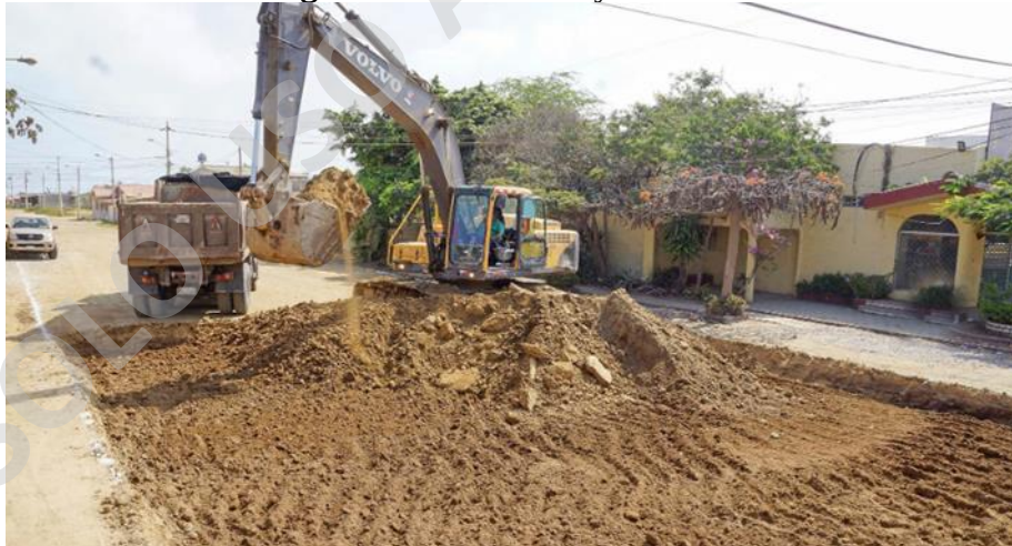
Imagen 57: Demolición y Excavación
