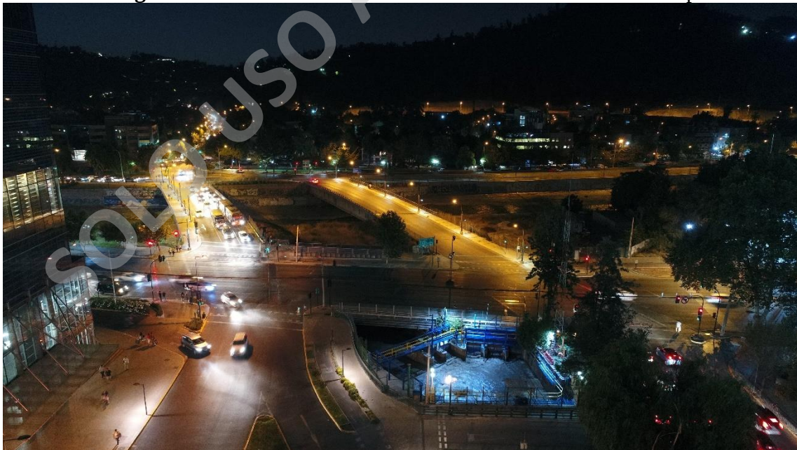
Imagen N° 9: Bocatoma El Carmen – Sociedad del Canal de Maipo
