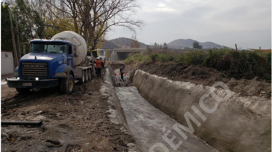
Imagen N° 14: Revestimiento Canal Batuco – Sociedad del Canal de Maipo
