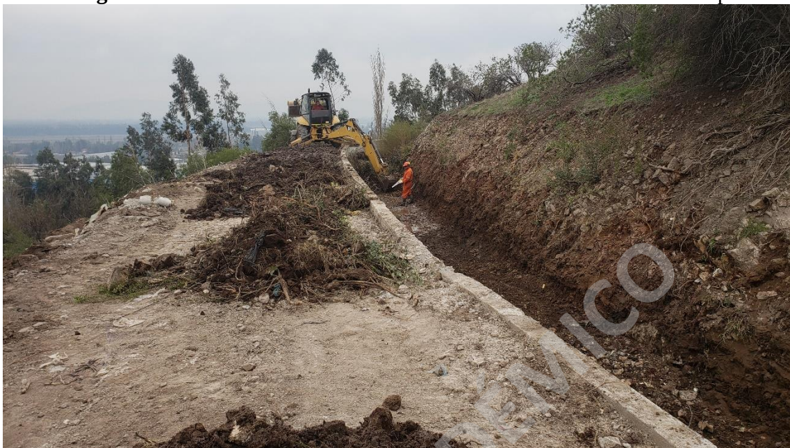
Imagen N° 16: Revestimiento Canal Batuco – Sociedad del Canal de Maipo
