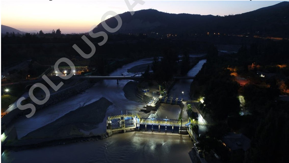
Imagen N° 3: Bocatoma San Carlos – Sociedad del Canal de Maipo
