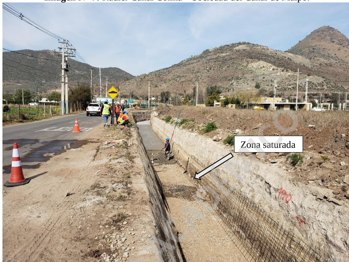
Imagen N° 7: Radier Canal Colina – Sociedad del Canal de Maipo.
