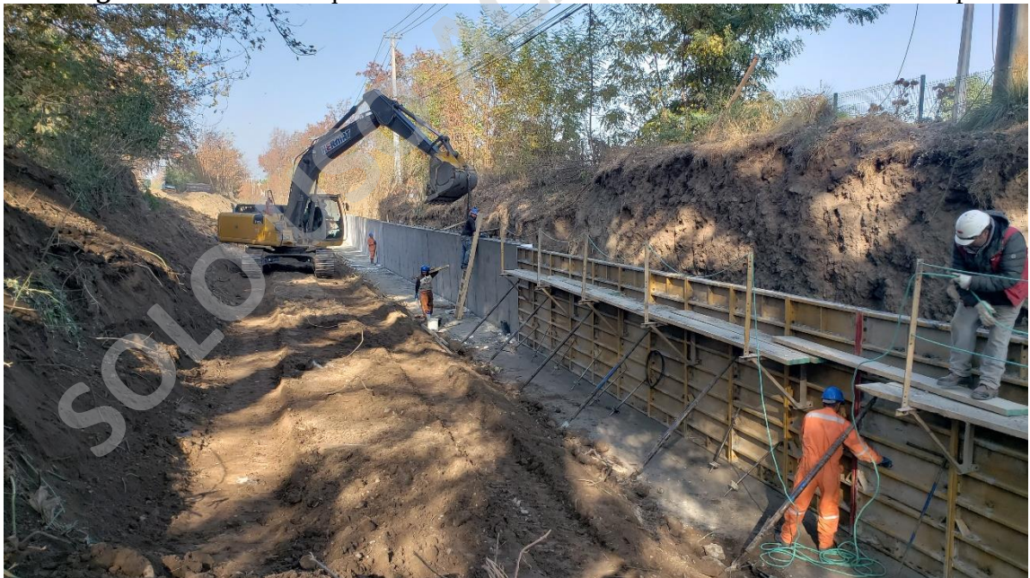
Imagen N° 11: Muro izquierdo Canal San Carlos – Sociedad del Canal de Maipo
