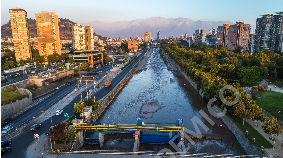
Imagen N° 10: Bocatoma La Punta – Sociedad del Canal de Maipo
