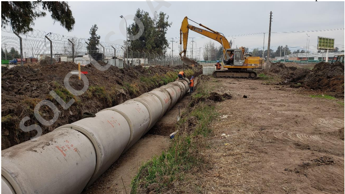
Imagen N° 15: Entubamiento Canal Lo Castro – Sociedad del Canal de Maipo
